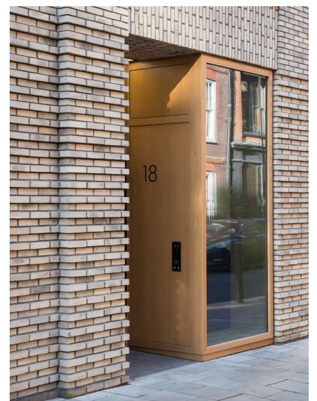
Synlig inngangsparti med godt gjennomførte detaljer.
