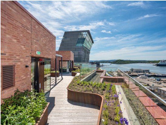
Rekkverk skal trekkes tilbake fra gesims.
