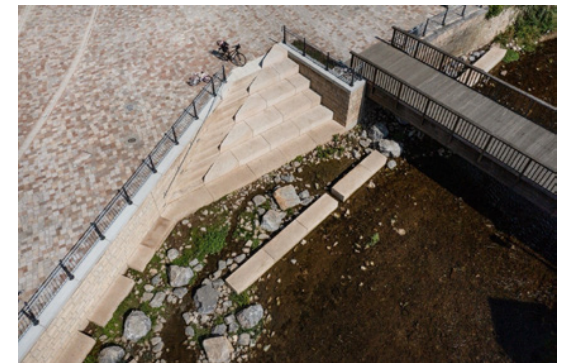
Eksempel på gangbro i tilknytning til torg og amfi. Foto: POLA
