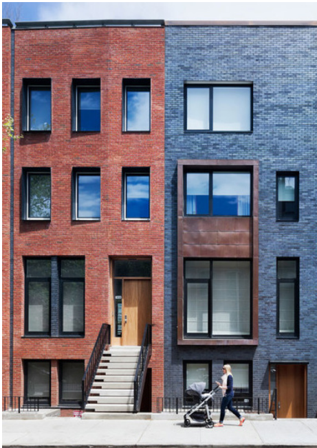
Eksempel på slektskap gjennom samme bygningshøyde og bredde.
