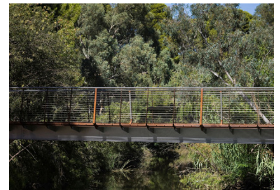
Eksempel på en lett brokonstruksjon. Foto: Sam Noonan
