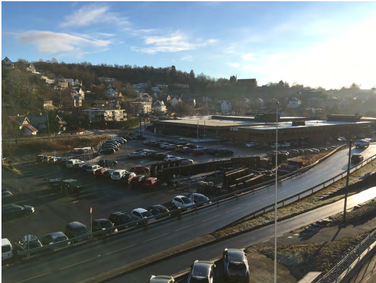
Fig. 24: Oversikt over planområdet. Nord- og vestfasaden av Conrad Mohrs veg 15.
