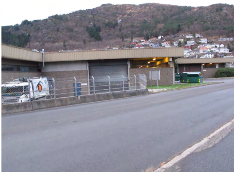
Fig. 44: Delar av austfasaden av Conrad Mohrs veg 15.
