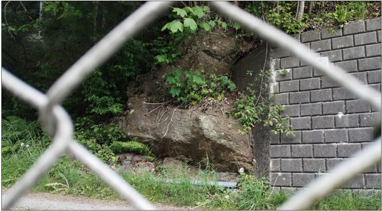
Figur 15: Fast fjell i dagen ved fotostopp 8 som er lokalisert nordøst for planområdet. Foto: Sunnfjord Geo Center.
