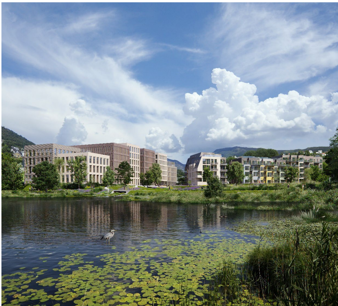
Figur 43: Planområdet sett mot nord fra Kristianborgvannet i sør (Sora, 2024).
