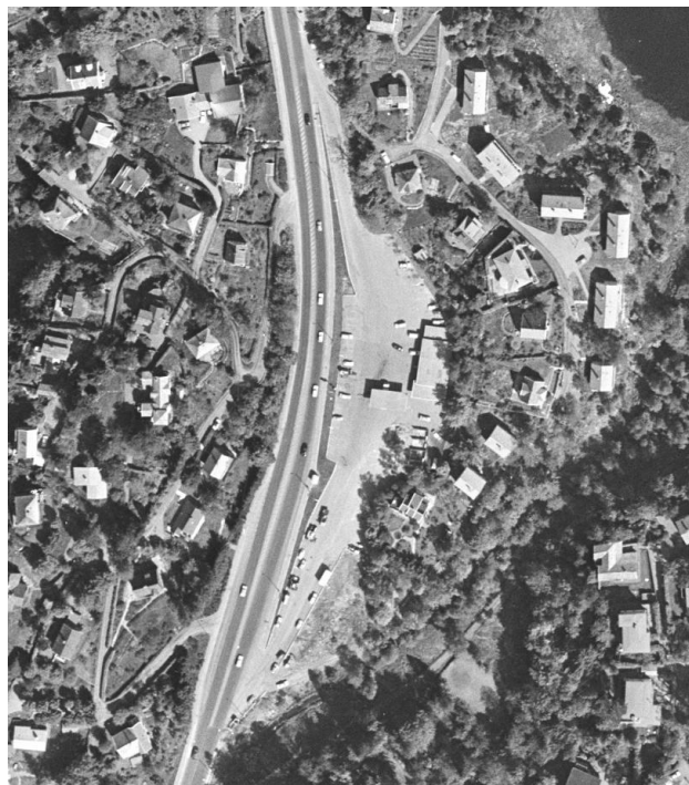
Figur 40 - Flyfoto 1970. Kilde: Bergenskart. Tjernvegen 11 og 13 er oppført, og næringsbebyggelsen i nr. 17 er etablert.
