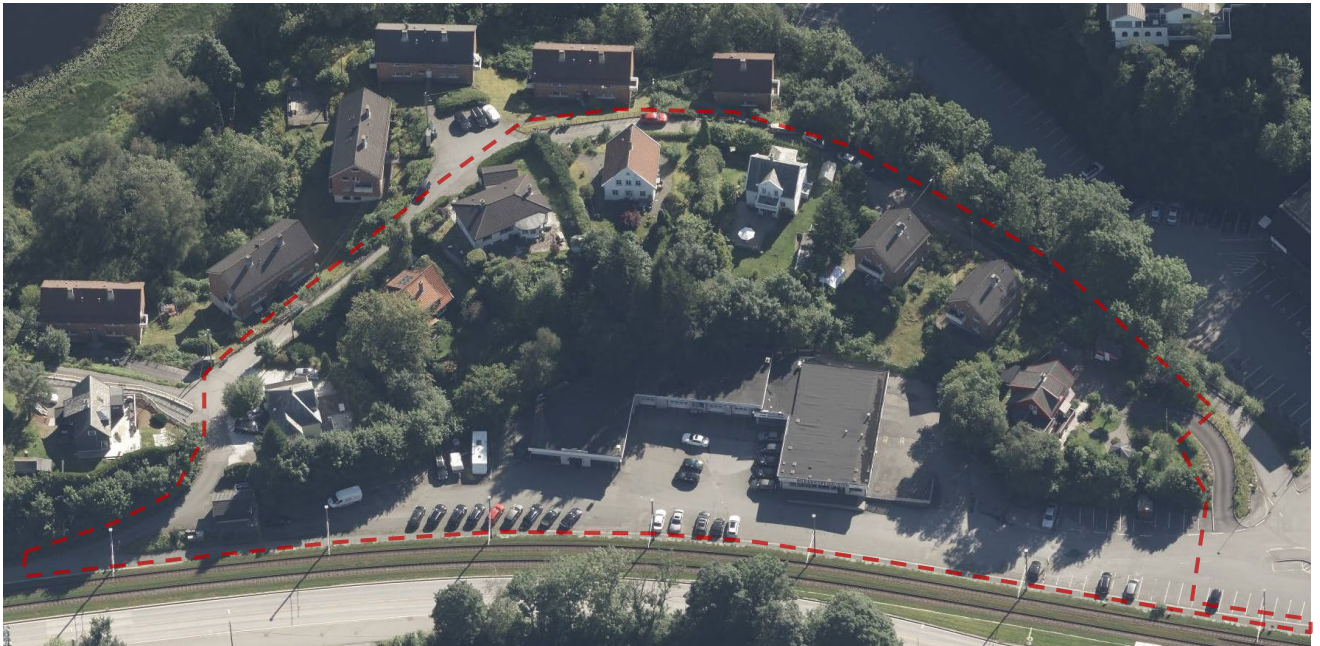
Figur 1: Skråfoto sett mot øst, med avgrensning av planområdet. Den lave næringsbebyggelsen midt i bildet er planlagt revet. Kilde: 1881.no.
