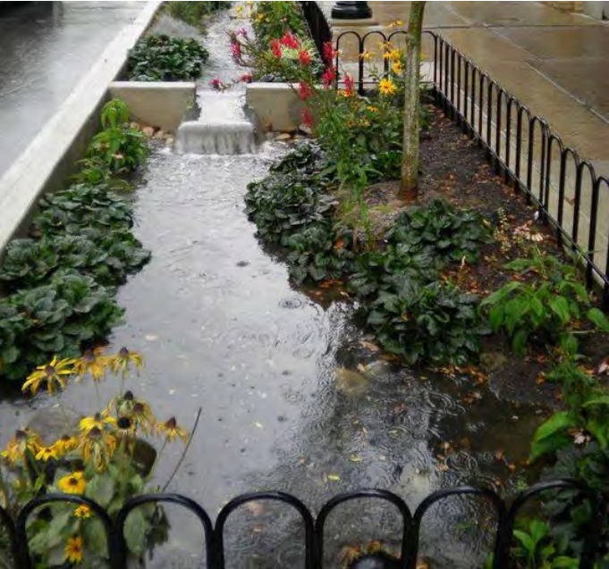
Regnbed håndterer overvann og gjør det til en ressurs som utnyttes både til vanning og som en dynamisk kvalitet i byrommene
