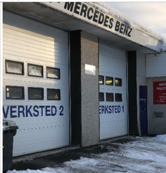
Bilde 9: Fasadeplater på midtdel - ikke farlig avfall
