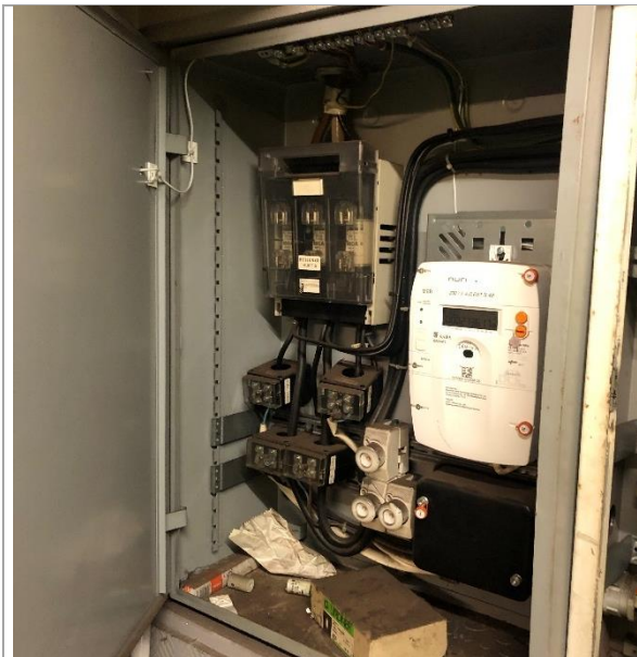
Bilde 18: Sikringsskap
