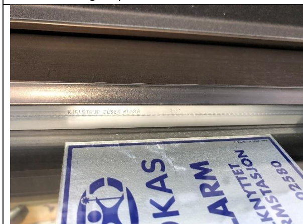
Bilde 24: Vindu fra Kjelstrup Olsen Glass, 1987. Inneholder trolig klorparafiner.
