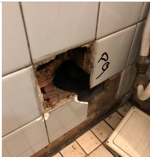
Bilde 10: Det ble avdekket vinyltapet bak fliser
