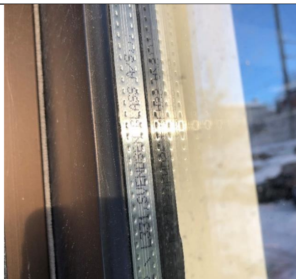
Bilde 23: Vindu fra Svendsen glass A/S. To perforerte linjer i avstandslisten.
