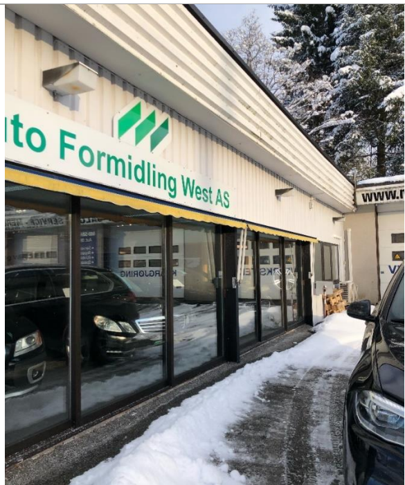
Bilde 2: Fasade mot sør
