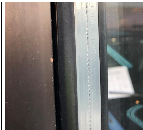
Bilde 22: Vindu fra Kjelstrup Olsen Glass, 1985. Inneholder trolig klorparafiner.
