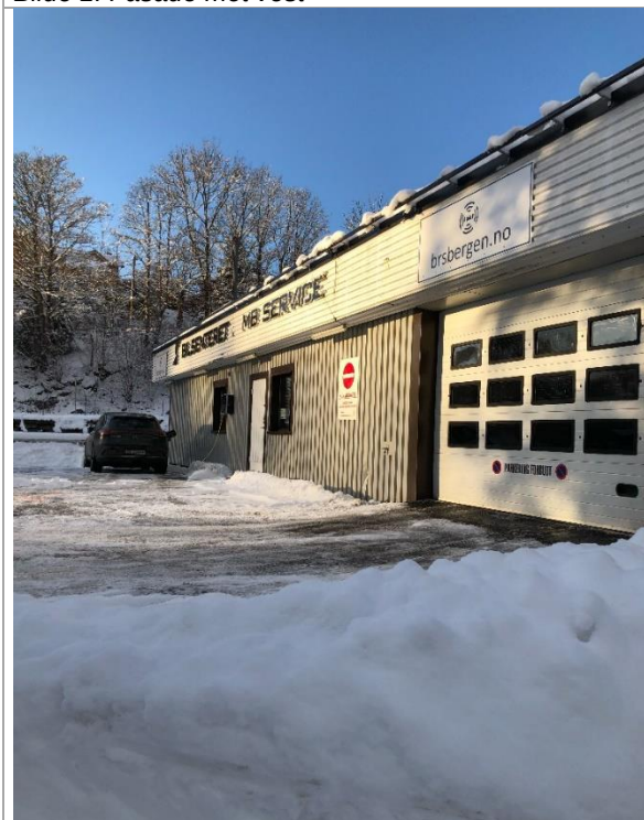
Bilde 3: Fasade mot sør
