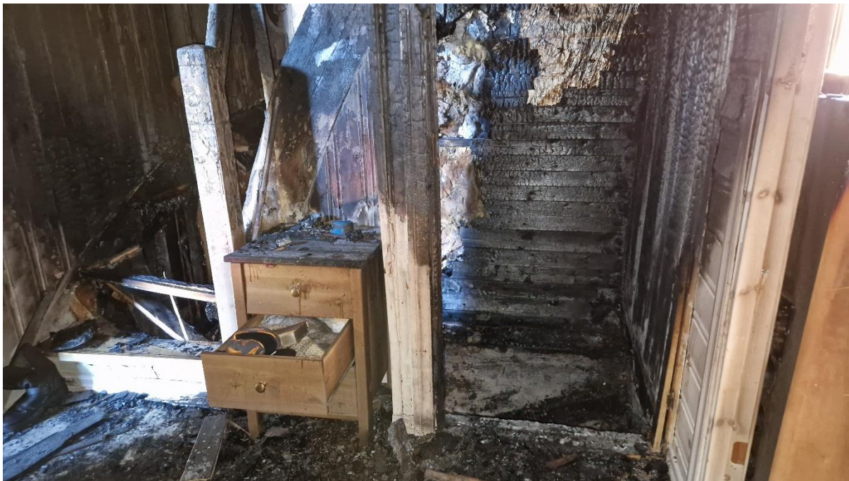
FIGUR 5 TRAPP I BOLIGENS FØRSTE ETASJE. TIL VENSTRE FOR KOMMODEN SER MAN RESTER ETTER TRAPPEN OPP TIL ANDRE ETASJE, MENS TIL HØYRE FOR KOMMODEN SER MAN NEDGANGEN TIL KJELLEREN.
