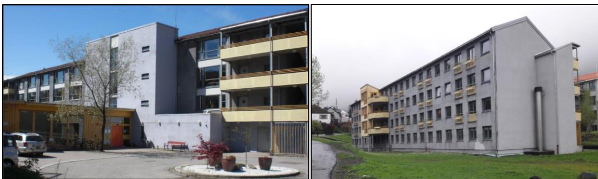
Figur 3.1.2: Til venstre: Sykehjemmets hovedinngang. Til høyre: Sykehjemmets fasade mot grøntområdet i vest.
