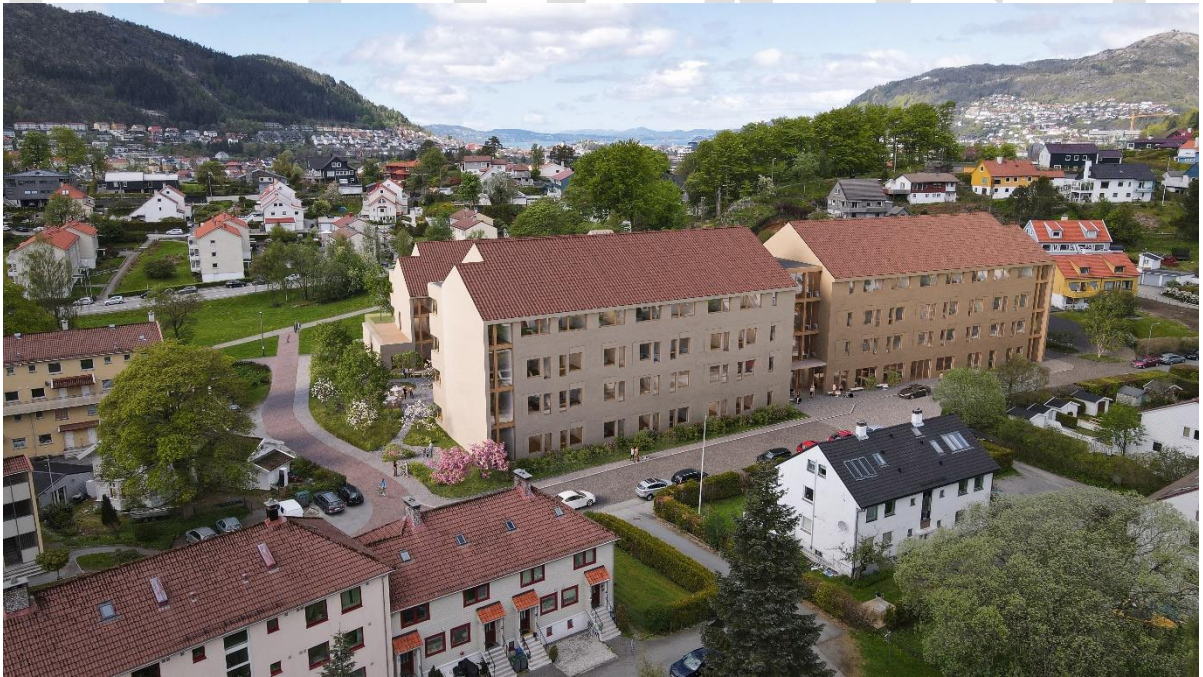
Figur 40. Drone perspektiv nytt sykehjem, fasade Adolph Bergsvei. Den hvite bygningen midt i bildet er nr. 34. og rekkehusene skimtes i høyre bildekant. (Kilde: Link Arkitekter)
