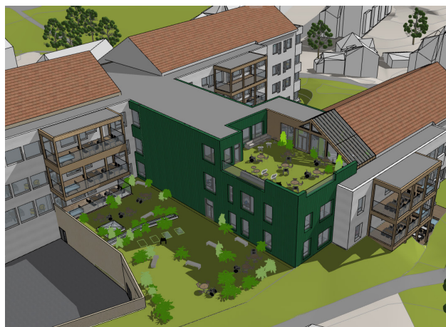
Flatt grønt tak på mellombygget
