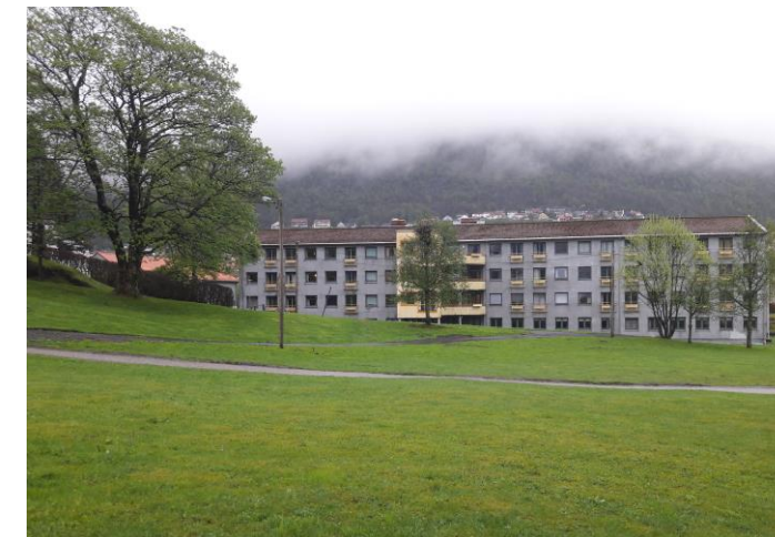
Gangveier gjennom grøntarealet mot Hagerupsvei. Sykehjemmet midt i bildet.
