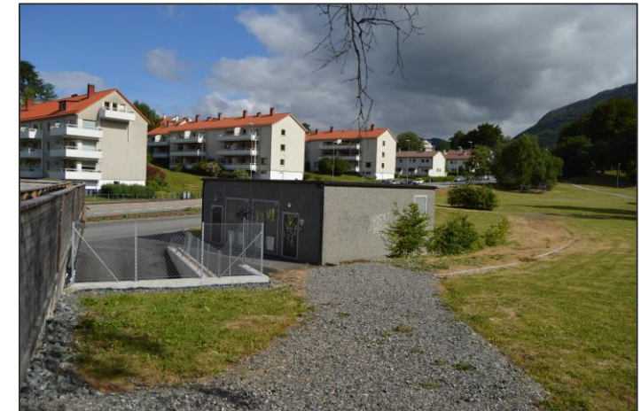
Likeretterstasjon bygget i forbindelse med bybanen. Gjerde på taket av butikken til venstre. Hagerupsvei i bakgrunnen.
