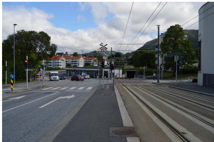
Foto tatt fra bybanestopp ved Sletten senter. Dagligvarebutikk midt i bildet. Tunnellinnslag for bybanen til høyre. Hagerupsveien går opp til venstre for butikken. Parkområde foran Slettemarken sykehjem ligger bak dagligvarebutikken.
