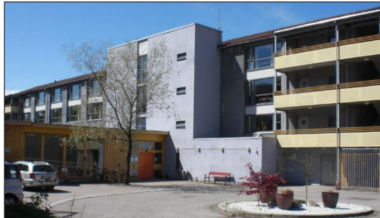
Adolph Bergsvei 33 Bygningen ble ombygget til sykehjem i 1995. Ny hovedinngang og trapp/heisbygg på langfasaden mot nr. 31.
