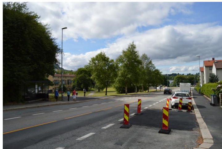
Hagerupsvei – ned mot Tveitevannet. Grønt-draget til venstre.
