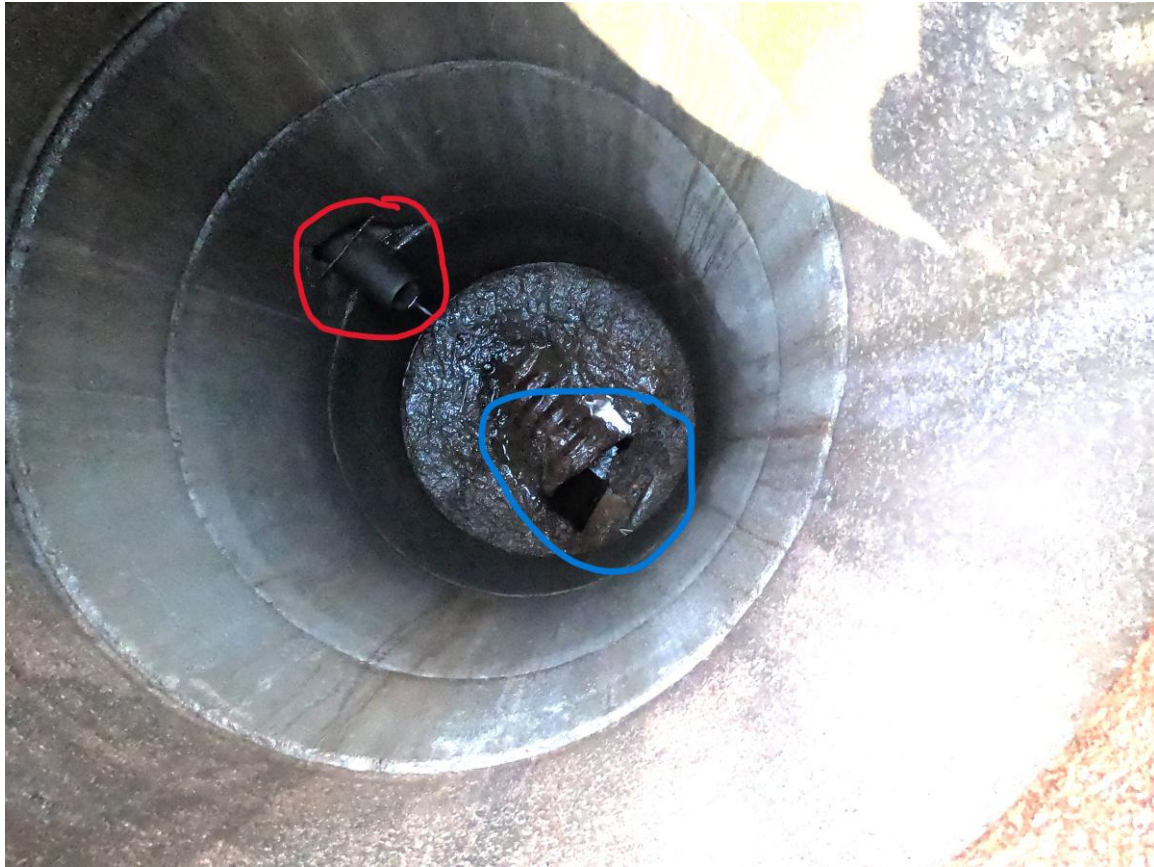
Figur 6 – Bilde kum ID 241083. Rød ring er innløp fra sandfangskum ID 745009. Blå ring viser rør fra kum ID 745026
