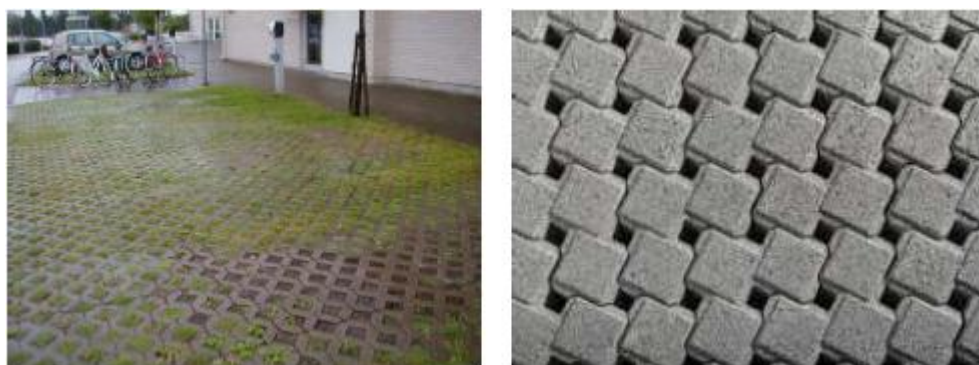
Figur 8 - eksempel på permeabelt armert grasdekke (venstre) og permeabel belegningsstein (høyre).
