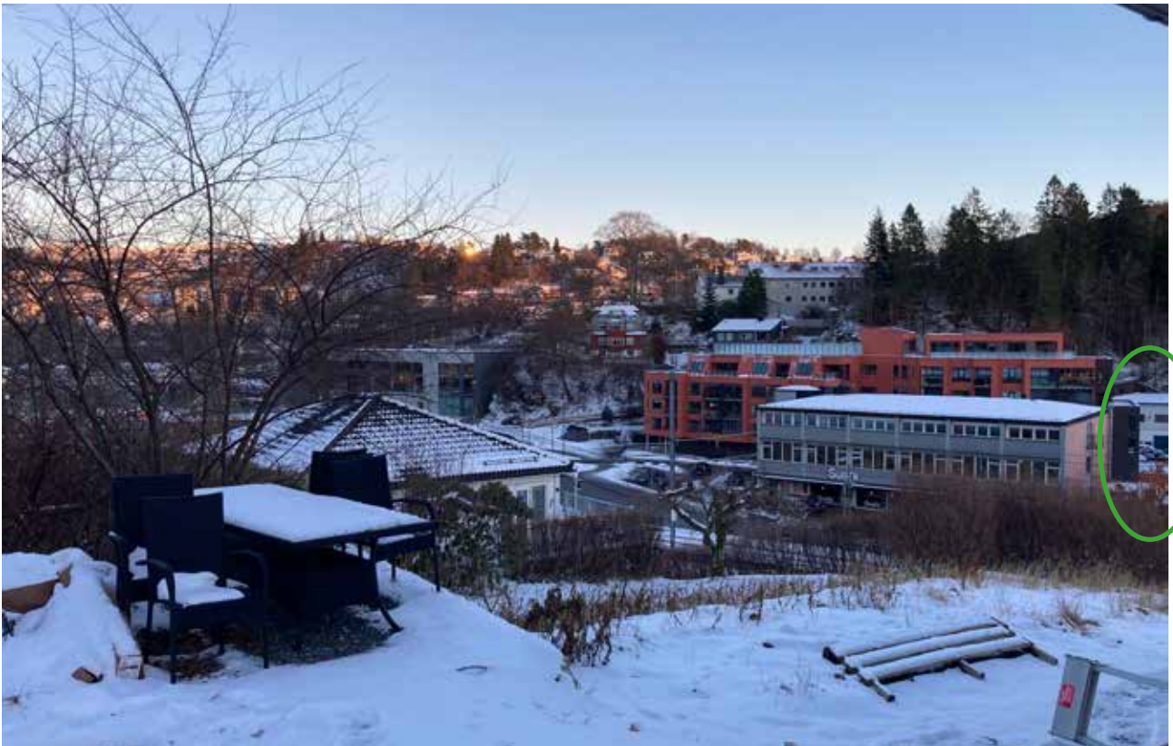
Oversiktsbilde tatt frå vest mot nord. Planområdet er markert med grøn sirkel. I forkant i bildet ser ein forretningsbygget langs vegen frå 1958 og den nye bustadblokka med byggeår 2022. Like til venstre for bustadblokka oppe i høgedraget ser ein ei av dei få eldre villaane like i nærleiken av planområdet med byggeår 1918.
