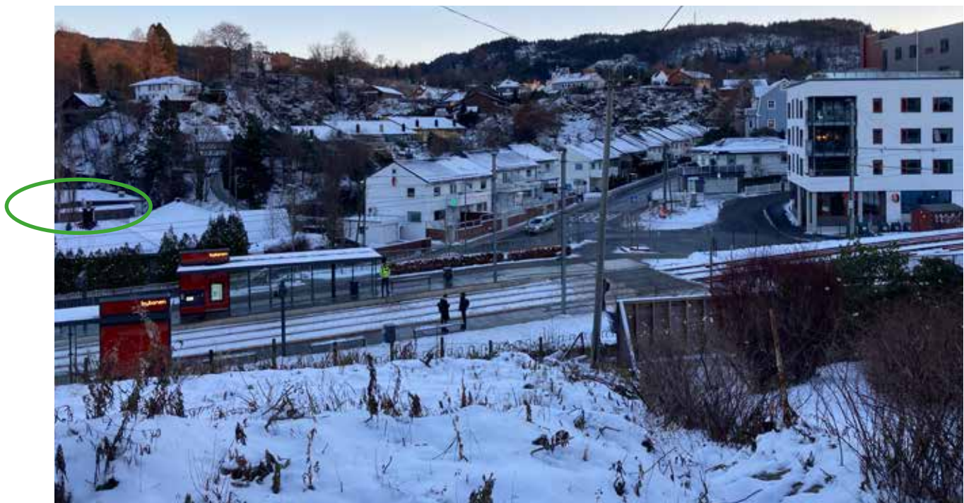
Oversiktsbilde tatt frå vest mot sør/søraust, frå motsett side av bybane-trasèen. Planområdet er markert med grøn sirkel. Her ser ein rekkehusa frå 1940-åra langs vegen i midten av bildet, og rekkehusa frå 1980-åra parallelt med desse litt lenger opp i terrenget. Ein får også eit heilskapleg inntrykk av bustadområdet som pregar kulturmiljøet her.
