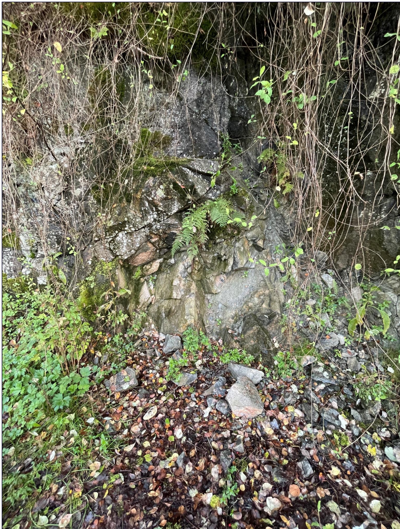
Figur 26 Bilde 6 er nærbilde av den steile fjellskrenten som går langs hele tiltaksområdets sørlige grense. Gneisen med den sterke kaledonske overpregningen er meget oppsprukket, og det ligger en rekke mindre steinsprangprodukter av nyere dato langs hele skrenten. Bilde av Skrið
