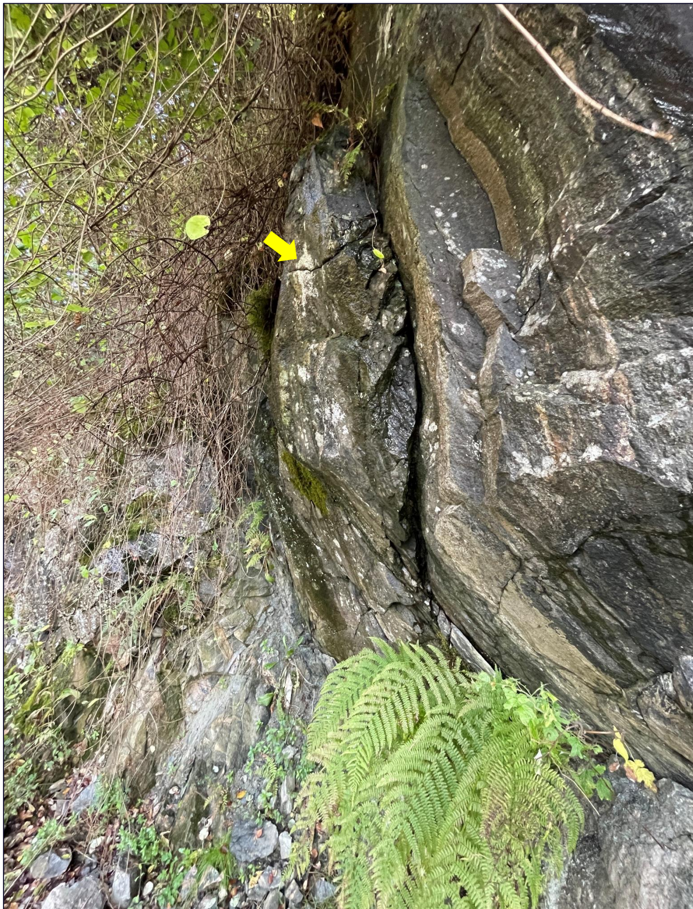
Figur 28 Bilde 8 er nærbilde av den steile fjellskrenten som går langs hele tiltaksområdets sørlige grense. Gneisen med den sterke kaledonske overpregningen er meget oppsprukket, og steinsprang fra denne skrenten kan forventes. Blokken som er indikert med gul pil er anslått til å veie over 1 tonn, og kommer til å falle ut fra skrenten etter videre mekanisk forvitring/frostsprengning. Bilde av Skrið
