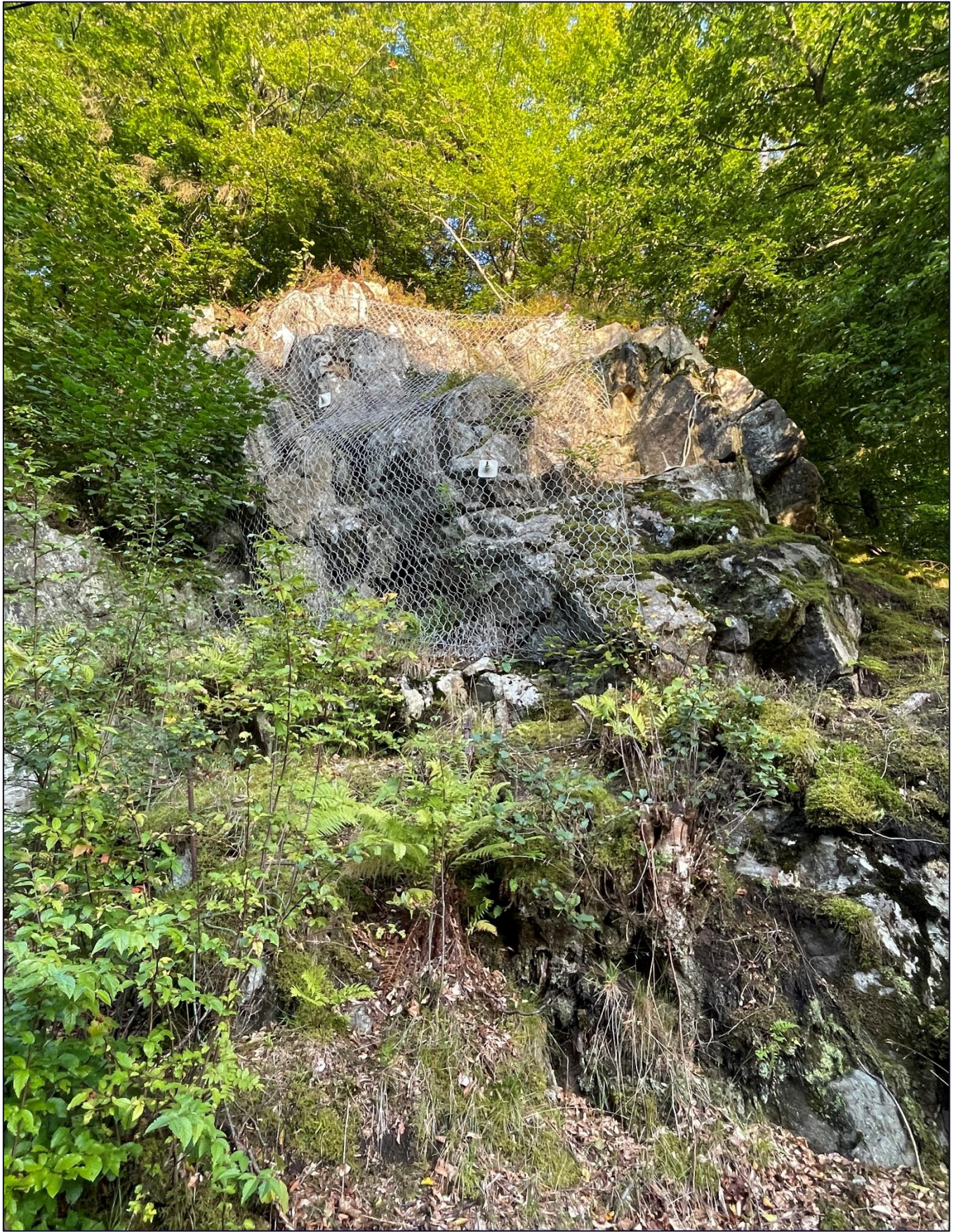
Figur 32 Bilde 12. Faresoner for skred i lokal arealplan for Bergen kommune ble definert i det bratte terrenget på nabotomten mot nord grunnet disse bratte skrentene som vist i bildet. Aktsomhet for skred på tiltaksområdet utløses av at tomten grenser til den kartlagte faresonen for skred. På nabotomten er de bratte skrentene sikret med netting, noe som anbefales vurdert for tiltaksområde. Bilde av Skrið
