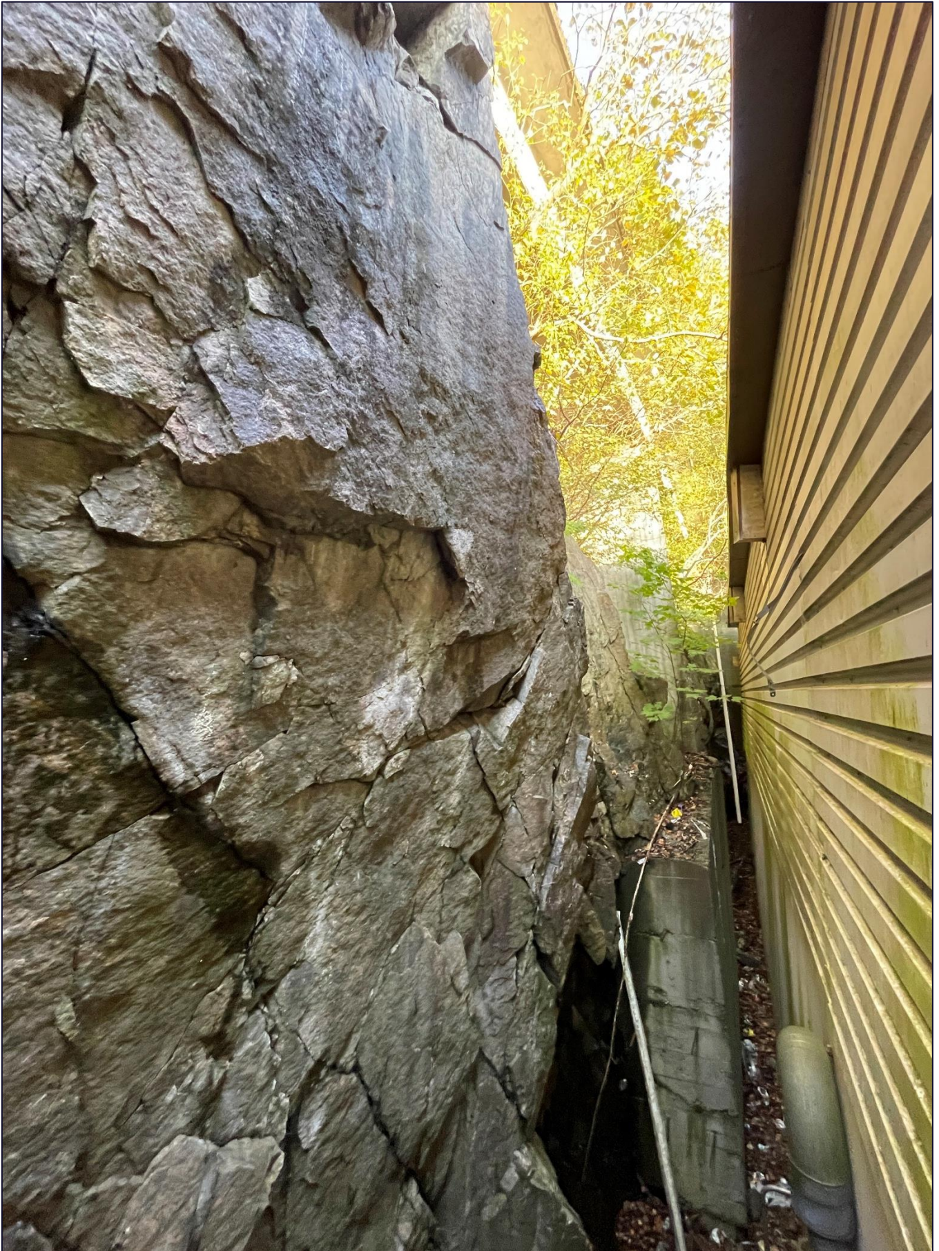
Figur 30 Bilde 10 er tatt like bak den nordligste delen av bygningsmassen på tiltaksområdet, og viser hvordan den massive gneisen er oppsprukket. Bilde av Skrið
