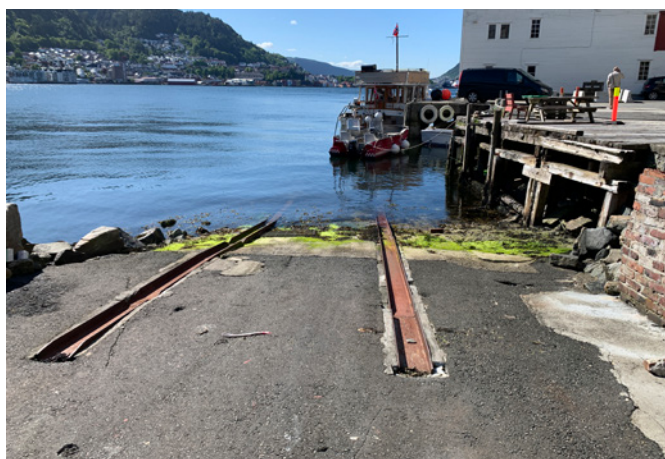
Eksisterende slipp bevares og rustes opp.
