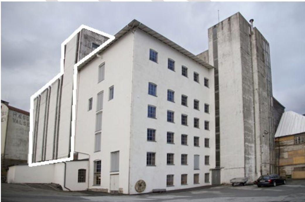
Figur 48. Nye mølle er bygget til på nordsiden av Gamle mølle.
