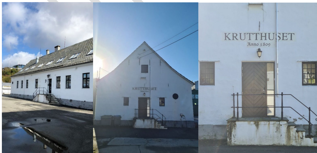
Figur 18. Fasader krutthuset. (Bilde til venstre er hentet fra www.ne.no )
