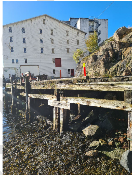
Figur 56. Trekai framfor gamle silo.
