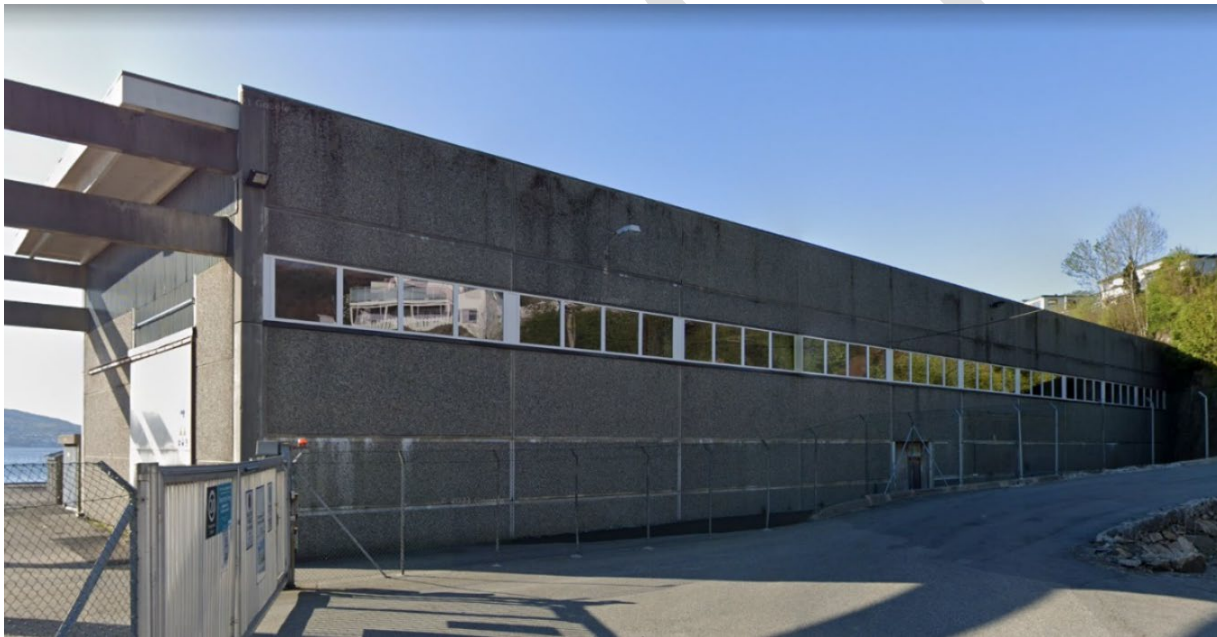
Figur 21. Foto av Hegrenesveien 15D.
