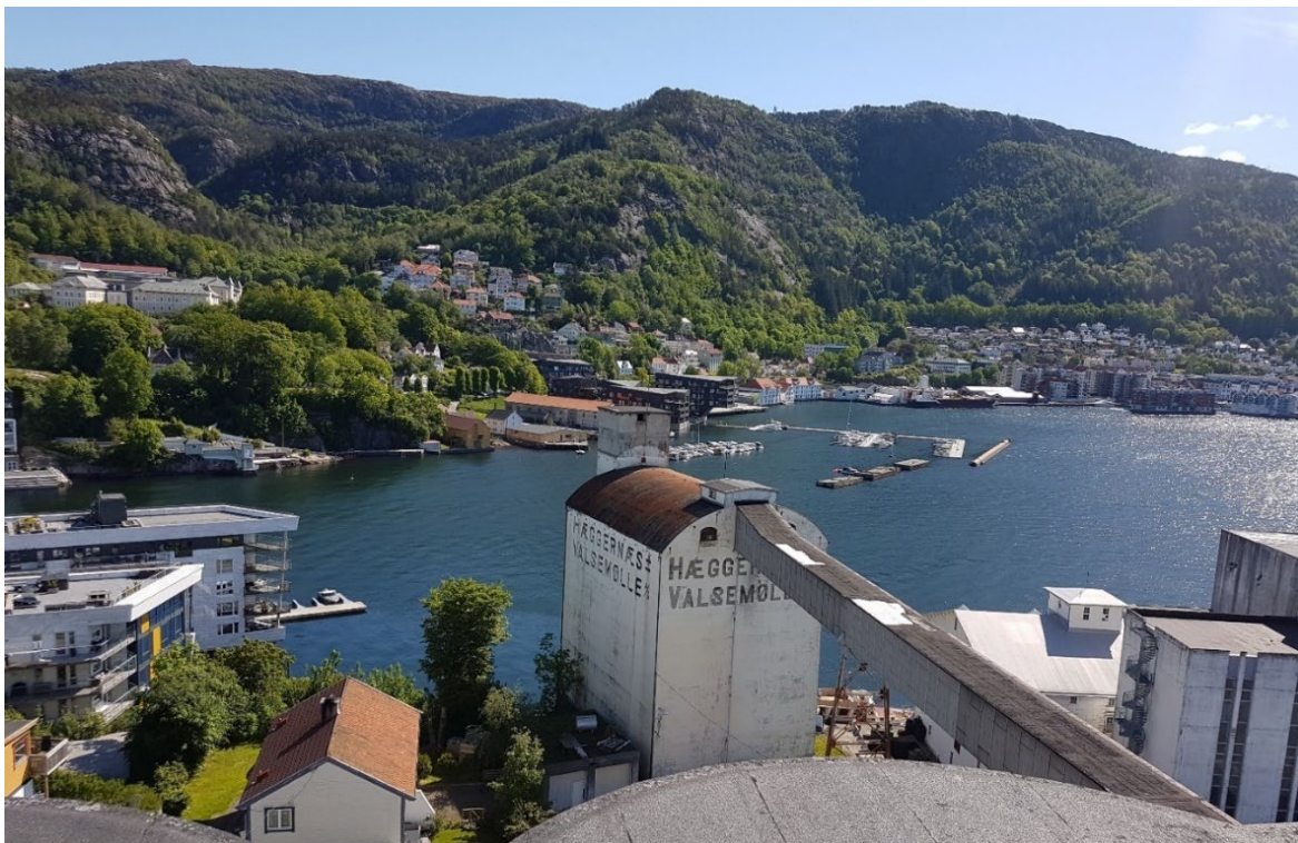
Figur 51. Gamle silo i dag. Bildet er tatt fra taket på havnesiloen. (Foto: ABO Plan & Arkitektur AS).
