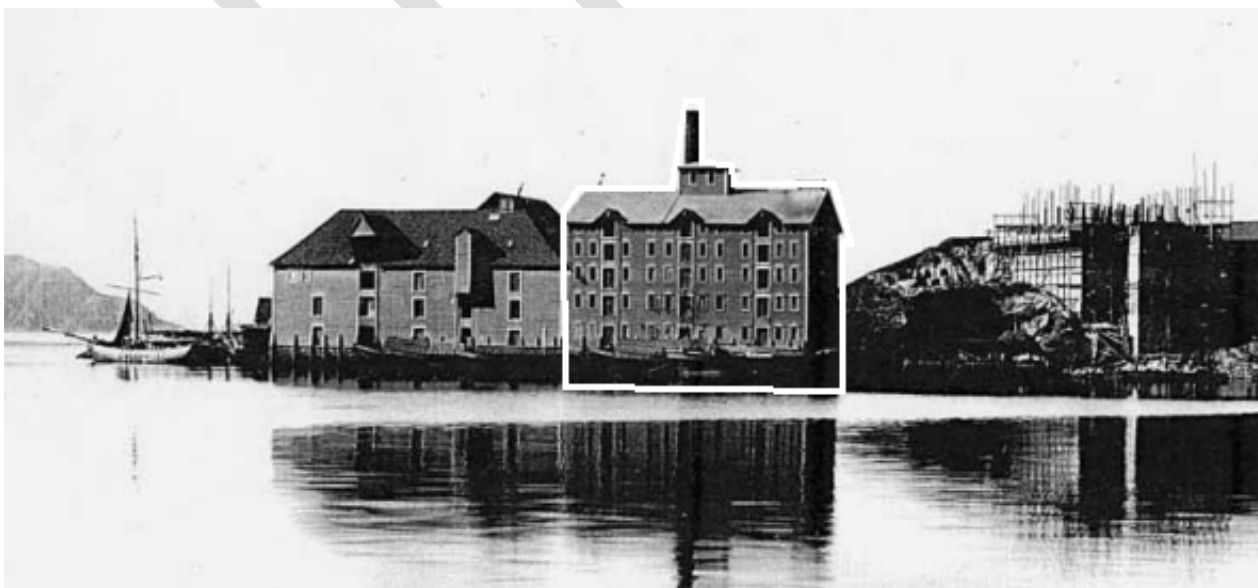
Figur 41. Østsiden av nye pakkhus, bilde tatt ca. 1899. Til høyre seg man at kornsiloen er under oppføring. (Kilde: Universitetet i Bergen).
