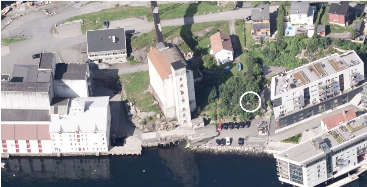
Figur 60. Plassering av bunker vist på skråfoto. Den ligger plassert i en bratt skråning mot parkeringsplass og bebyggelse i Nyhavn.
