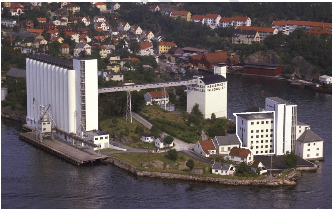
Figur 46. Gamle mølle etter at melsilo ble oppført. (Bilde: Widerøes Flyveselskap, 1964).
