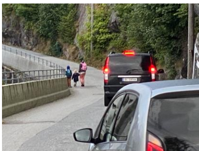
Figur 5. Breiviksveien i nord har smal kjørebane, ingen fortau eller sideterreng/skulder.
