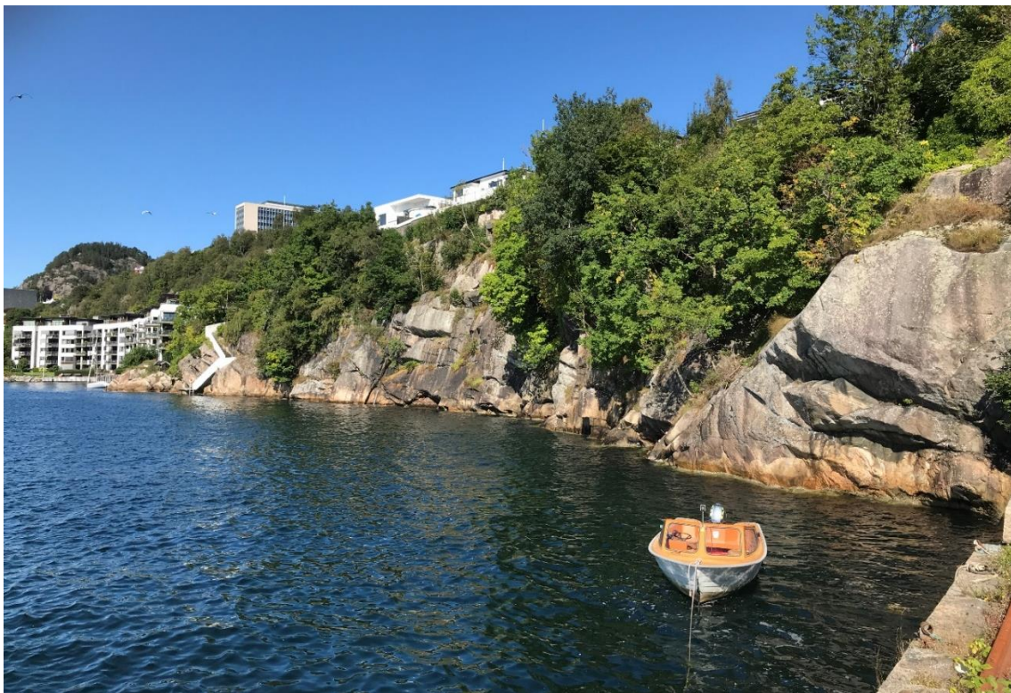
Figur 8: Foto som viser fjellskjæring der hovedfoliasjon har relativt bratt fall og fallretning mot øst.
