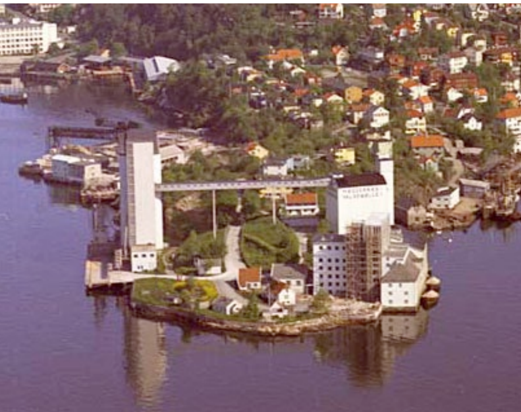
1963. Melsiloen er under oppføring, gamle mølle har fått to nye etasjer, kaien foran gamle mølle er fylt ut og gamle pakkhus er en etasje høyere.
