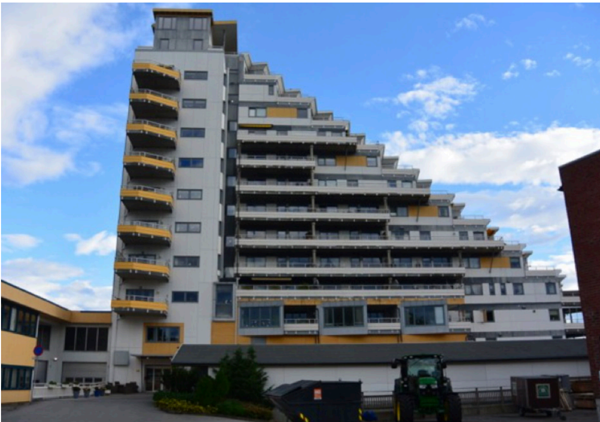
Figur 4 Silo i Levanger ombygget og påbygget til boligformål.
