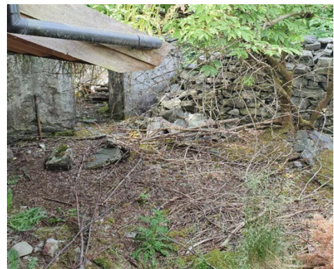
Figur 3-6 Rester fra tidligere løe/fjøs.
