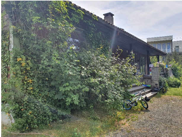
Figur 17 Fasade gnr. 40 bnr. 1007. Kledningen er i tre. Taket er tekket med tegl. Det er to skorsteiner på huset.
