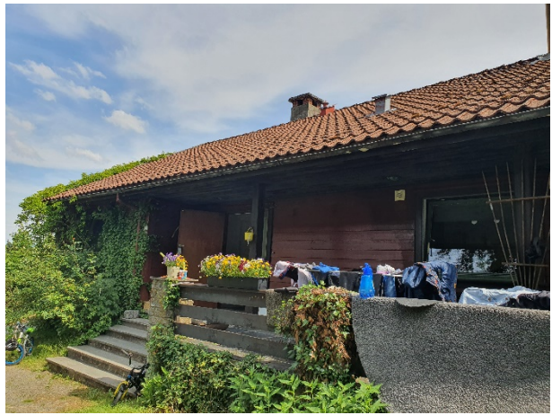
Figur 17 Fasade gnr. 40 bnr. 1007. Kledningen er i tre. Taket er tekket med tegl. Det er to skorsteiner på huset.
