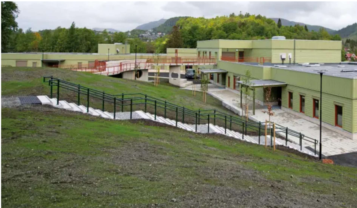
Figur 7 Eksempel på terrengtrapp i betong, med rekkverk i 2 høyder, ved Tveiterås skole
