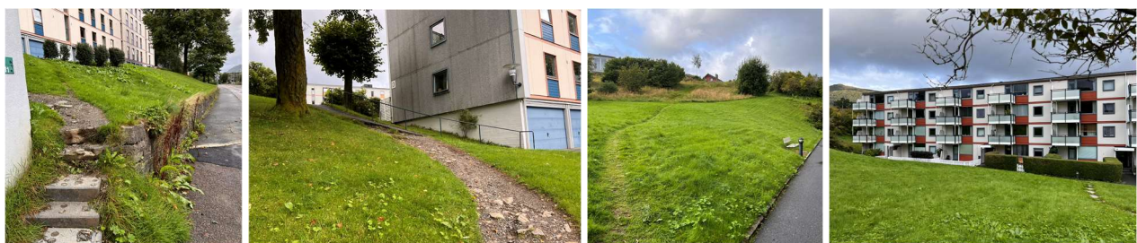
Figur 4 Provisorisk trapp Bratt skråning m/rekkverk
