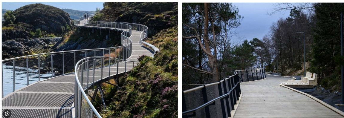
Figur 10 Konstruksjon i gitter, på Eldhusøya (t.v) og i treverk på Løvestien (t.h.)
