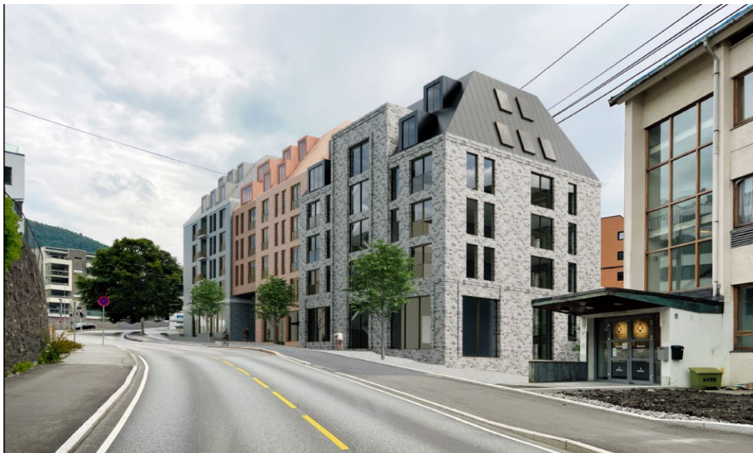
Figur 9. Fasade mot Minde Allé.
