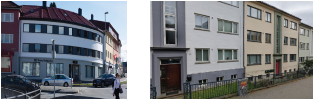
Figur 55. Eksisterende murbebyggelse i nærområdet.
