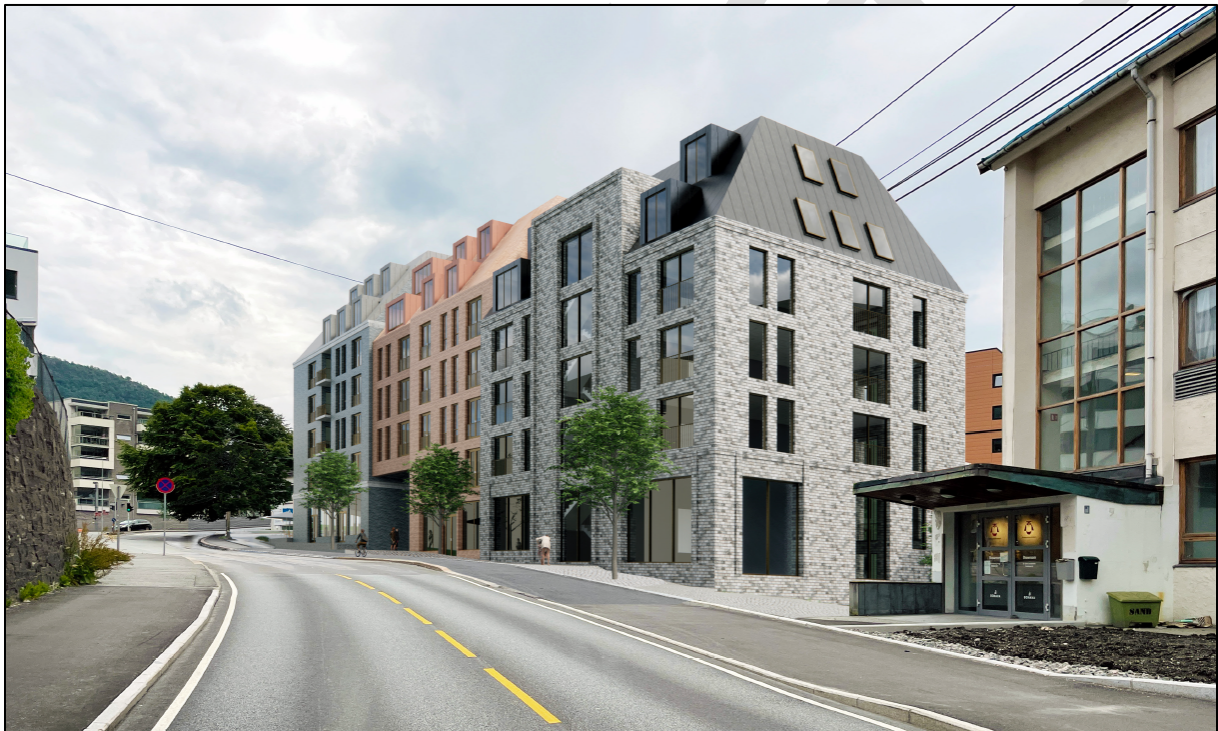
Figur 37. Fasade mot Minde Allé
