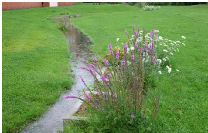
Figur 3 - Gresskledd vannvei/infiltrasjonsgrøft
