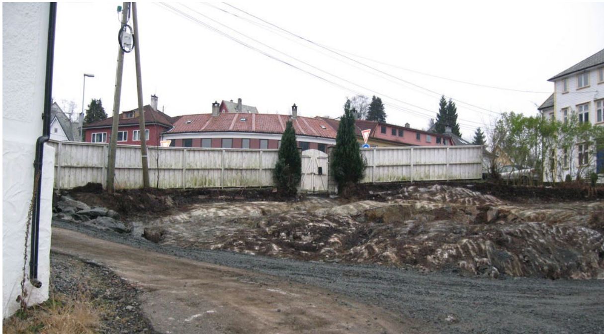
Figur 16: rensket/fjell i dagen på tidligere bebygget boligtomt like nord for Storetveitvegen 19 (hvitt hus til høyre i bildet). Storetveitveien går bak det hvite gjerdet (25.03.25)
