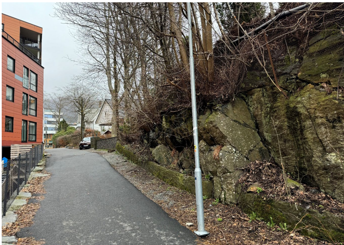
Figur 10: Eikeveien, sett mot nord, med skjæring og blottlagt fjell like ved plangrense (25.03.25)
