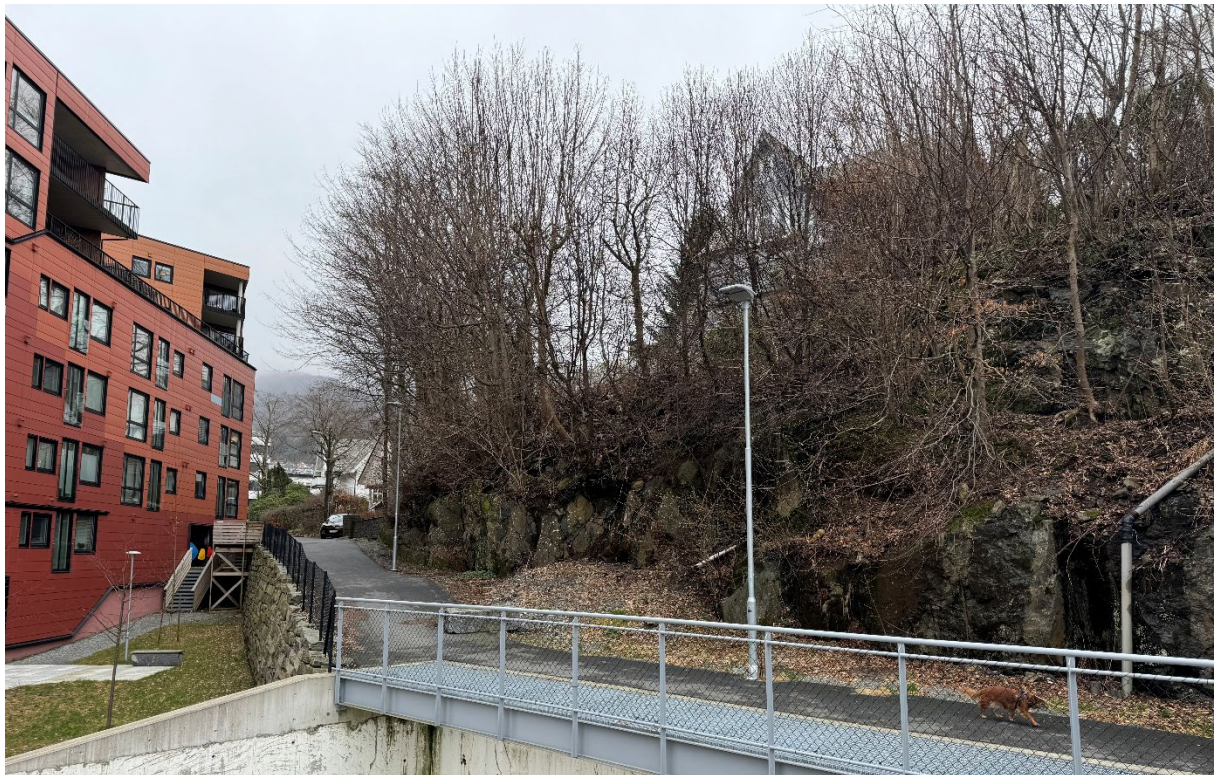
Figur 13: Eikeveien, sett mot nord, med skjæring og blottlagt fjell like ved plangrense Vegetasjon og villa til høyre i bildet er innenfor planområdet (25.03.25)
