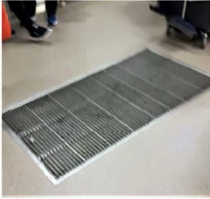
Referansebilde av gulvrist med sandfanger og sluk
