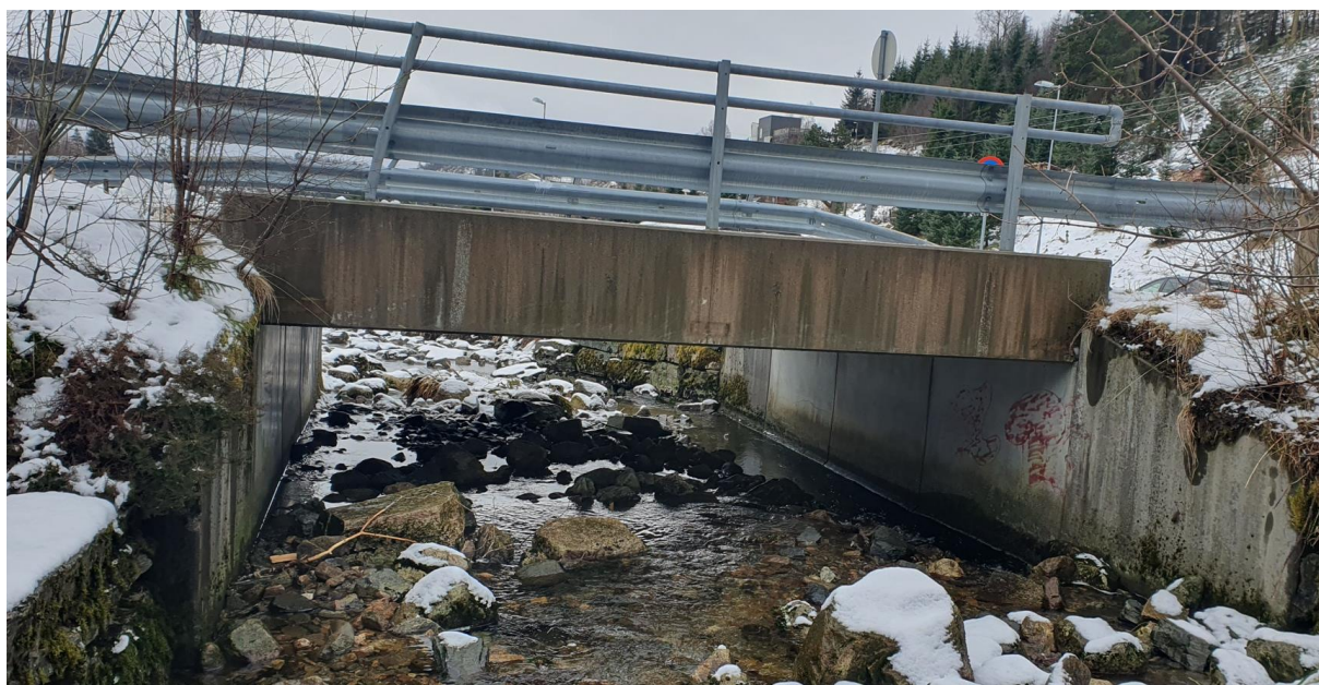
Figur 5: Bru 3 har lysåpning på 5 x 1,4 m. Landkar i betong. Flomvei vurdert som diffus (vanskelig å fastslå ved øyemål).
