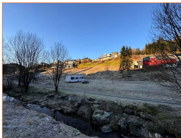
Figur 10 - Nedbørsfelt 2 observert på befarig 12.02.25
