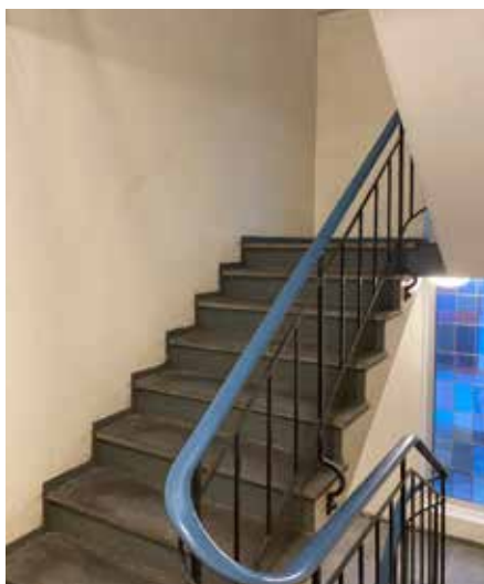
Detaljar frå originalt trappeløp opp til loftsetasjen.
