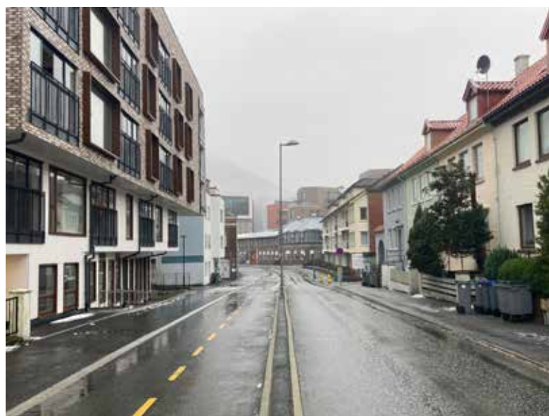
Nybygg lenger vest for planområdet – i fabrikkgangen.
