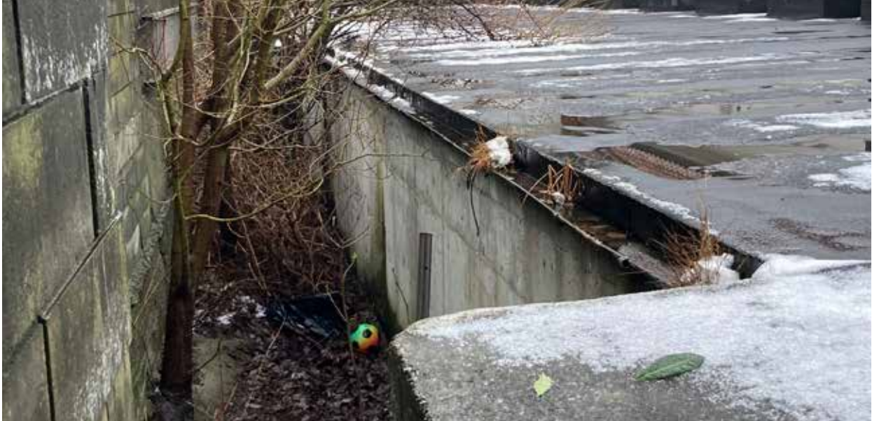
Fasade mot nord og og tilbygg.
