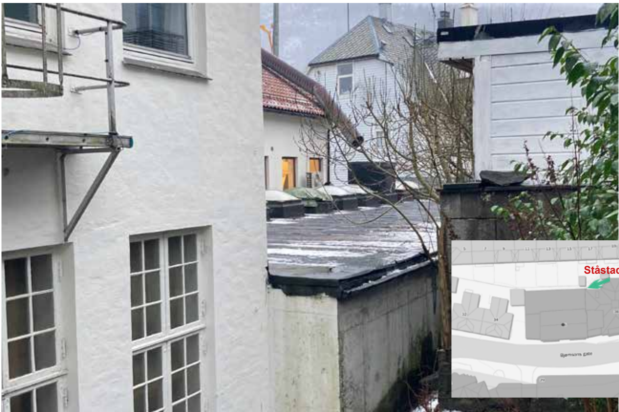
Frå venstre ser ein delar av nabobygget mot aust (kyrkja), i midten av bildet ser ein fasade og tilbygg til Bjørnsons gate 36, og bakers ser ein delar av bygget med adresse Bjørnsons gate 34.
