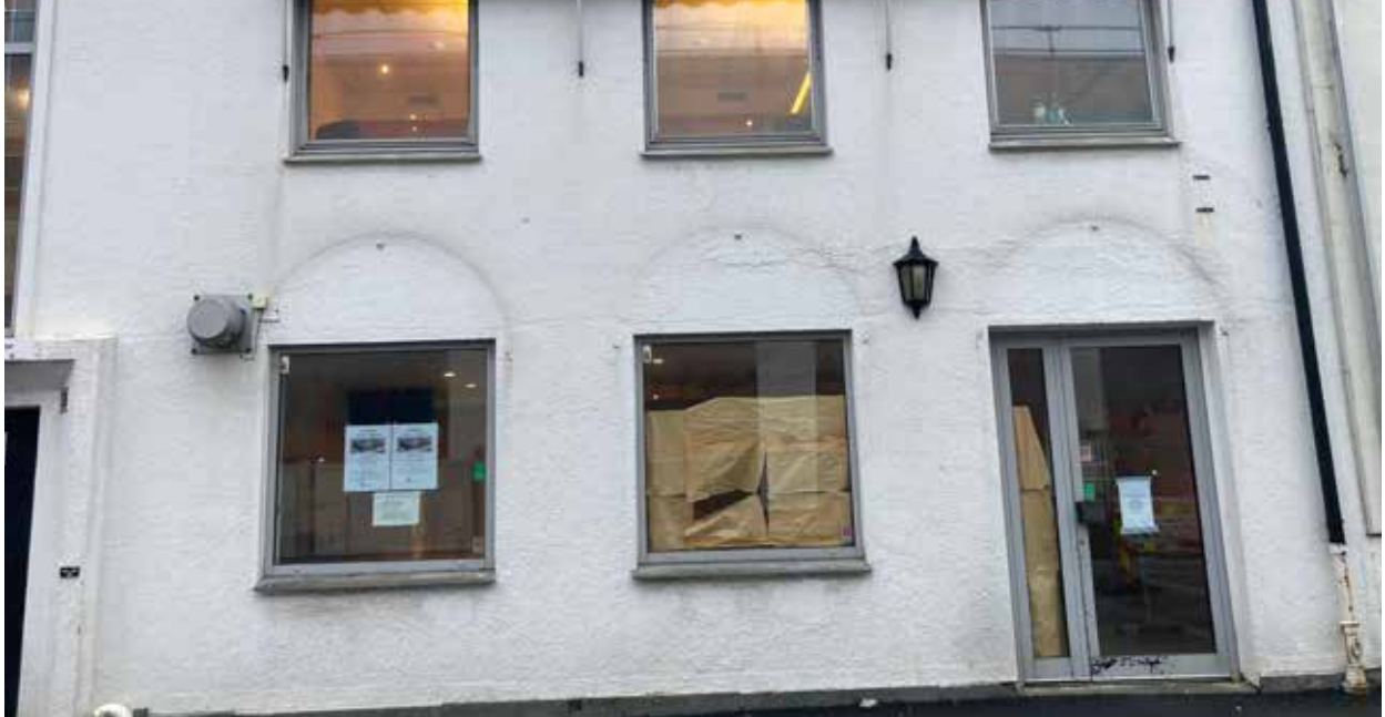
Aust på hovudfasaden er det sett inn ei dør istadenfor det originale vindauget. Andre vindauger også blitt skifta ut, men vindaugsomramming med vannbord i skifer.
