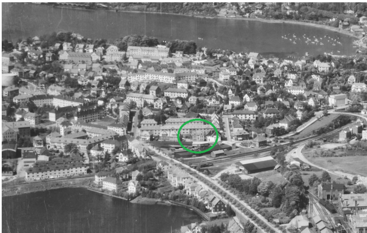
Planområdet 1935–39. Rett framfor huset på sørsida av Bjørnsons gate, det store trelastlageret til Andreas Olsen. Foto Widerøes Flyveselskap A/S. Henta frå UBB Billedsamlingen. https://marcus.uib.no/instance/photograph/ubb-w-sh-005150.html
