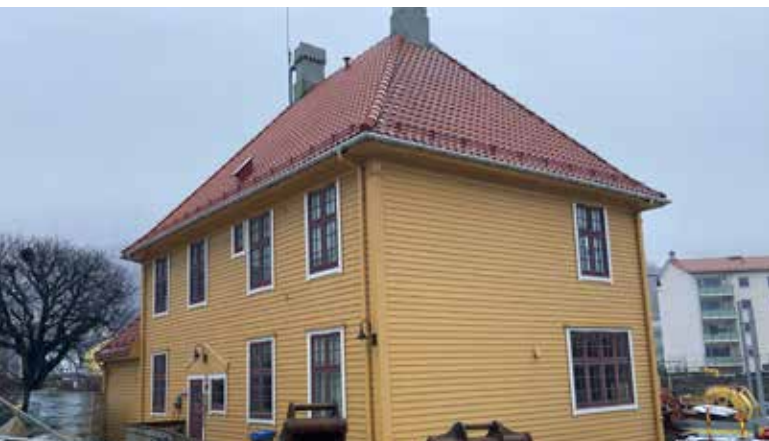
Den gamle stasjonsbygningen ligg like søraust for planområdet.
