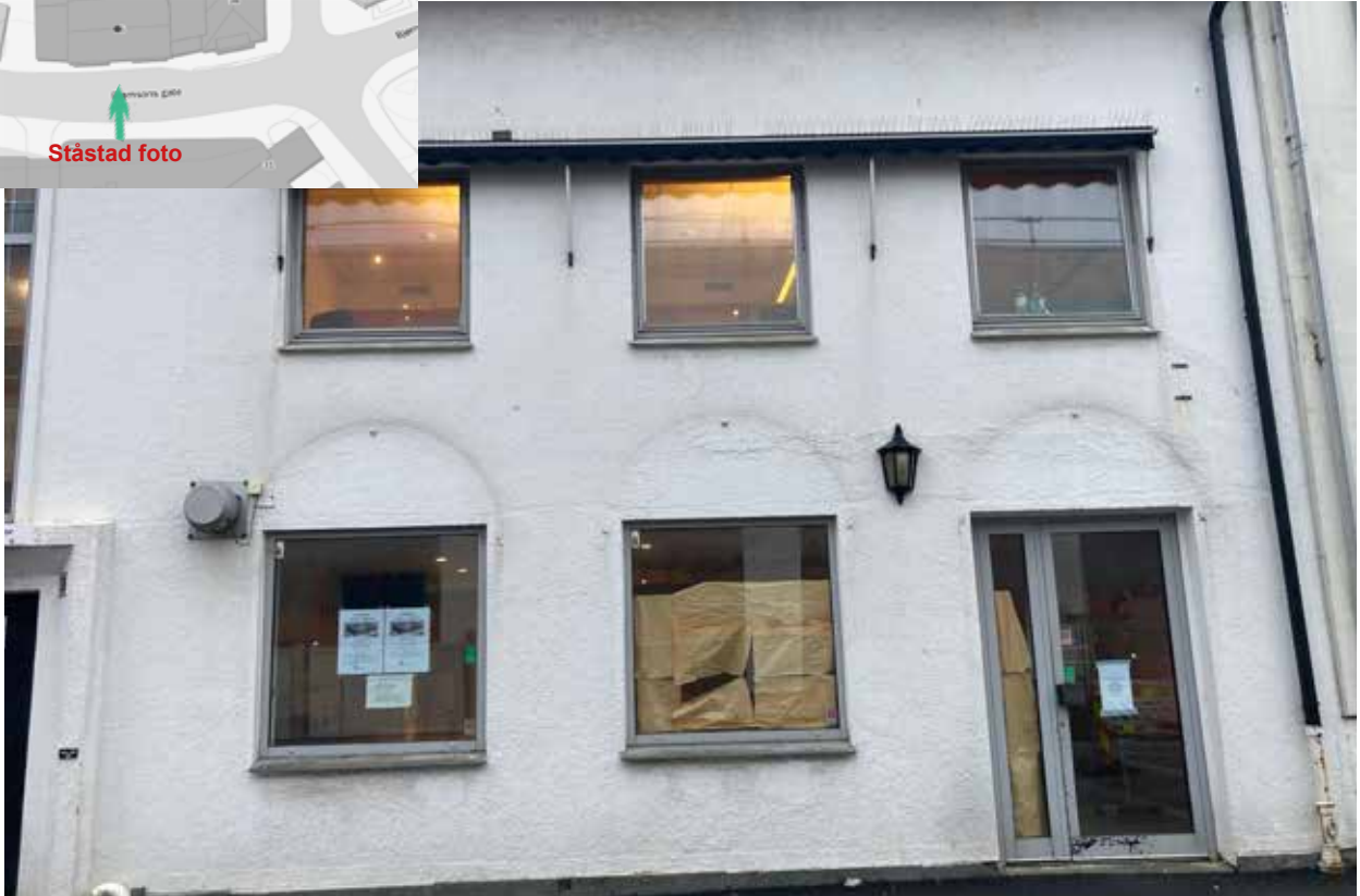
Aust på hovudfasaden er det sett inn ei dør istadenfor det originale vindaugget. Andre vindauger også blitt skifta ut, men vindaugsomramming med vannbord i skifer.
