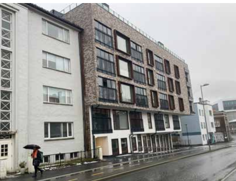
Nybygg lenger vest for planområdet – i Fabrikkgangen.
