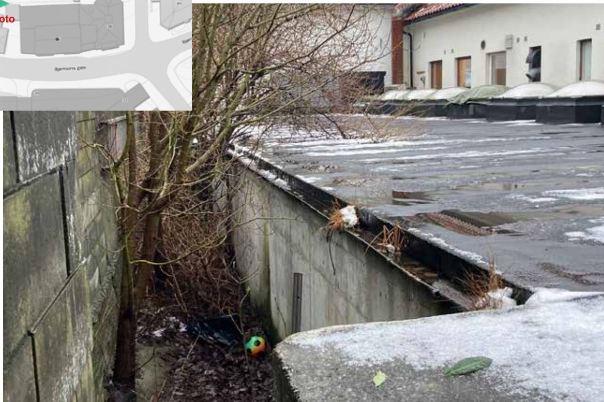
Fasade mot nord og og tilbygg.
