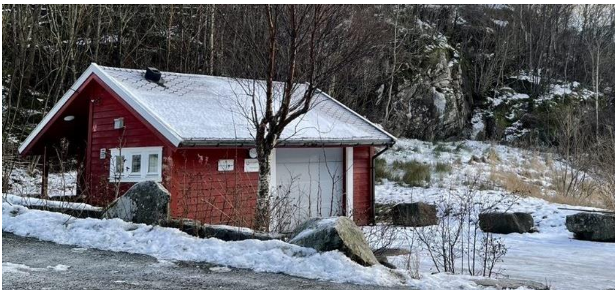
Figur 3-2: Eksisterende renseanlegg som skal erstattes av det nye renseanlegget.
