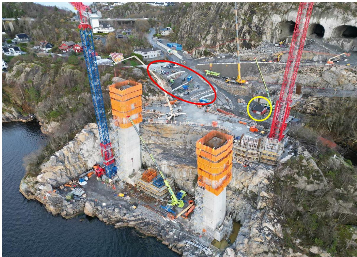
Figur 3-1: Planområdet benyttes i 2024 som anleggsområde for ny Sotrabro. Gul sirkel viser dagens renseanlegg. Rød sirkel viser det fremtidige renseanleggets omtrentlige plassering. Kilde: Sotralink.no, august 2024
