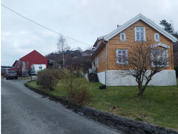
Figur 6 Sørveggen av våningshuset fra 1888, med uthuset i bakgrunnen. Vestre Drotningvik 5.
