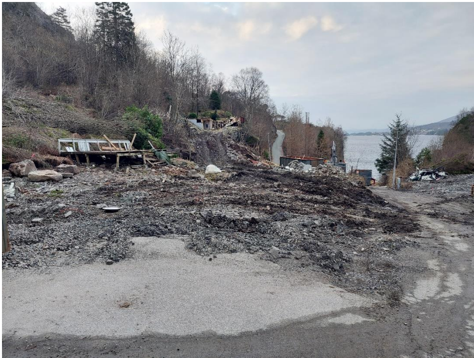
Figur 25 Planområdet i februar 2023, etter rivning av flere bygninger. Nytt daganlegg er foreslått på denne plasseringen.
