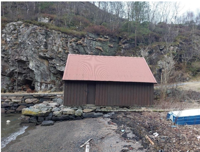
Figur 15 østveggen på nøstet som ligger nærmest kaien.
