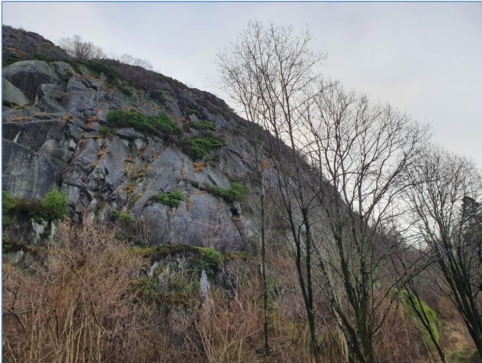
Bilde 1. Bilde av sentrale deler av østlig bergskrent.
