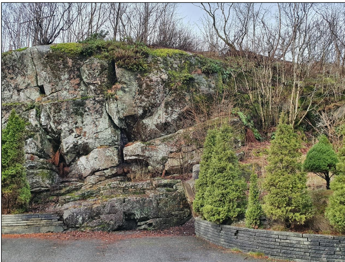
Figur 13. Mindre skrent/skjæring på vestsiden av Drottningvikveien som er mulig løsnemråde for steinsprang.
