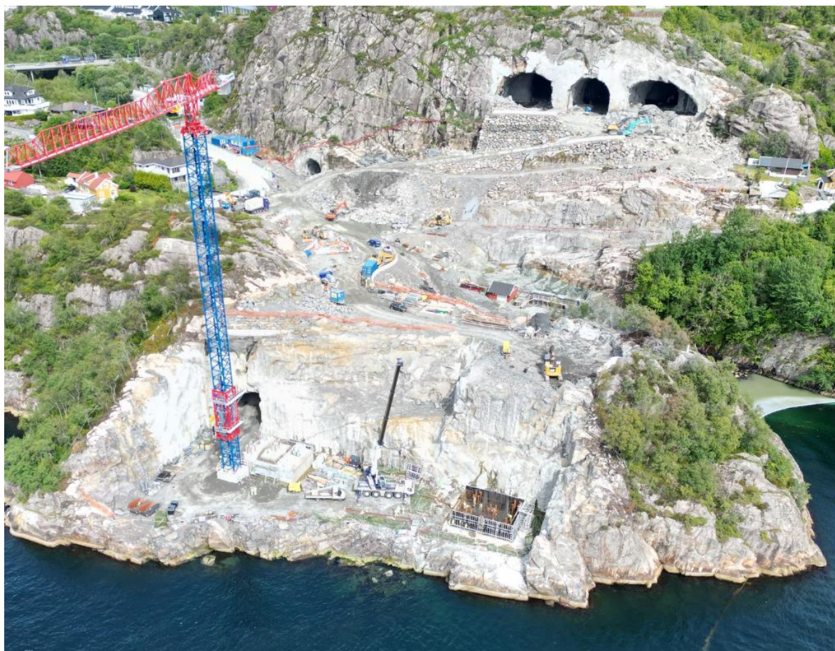
Figur 1. Dronebilde av anleggsområdet ved Drotningvik tatt 10.07.2024. (kilde: Rv.555 Sotrasambandet sin facebookside).
