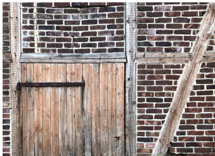
Figur 4-82 Detaljer fra bygningens konstruksjon og materialbruk, som viser den opprinnelige teglsteinsfasaden og det utmurte bindingsverket. Bilde: Bymiljøetaten, Bergen kommune.
