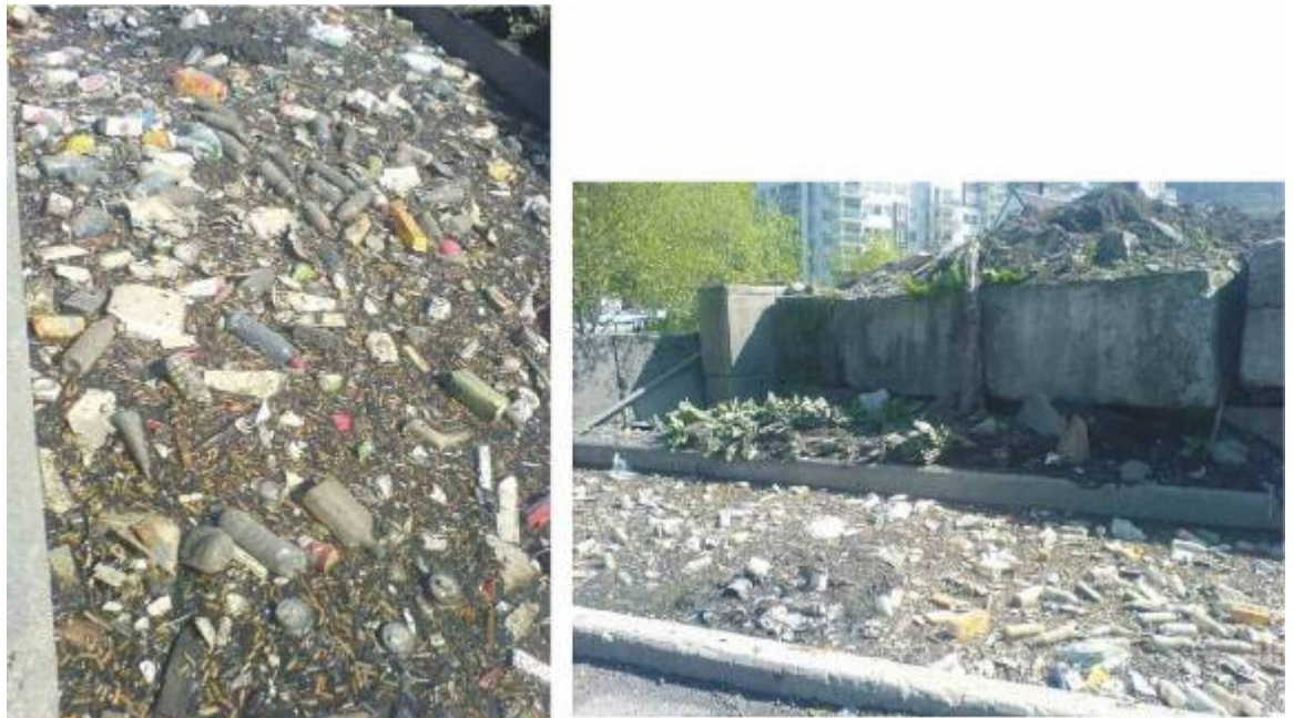
Figur 16. Masser som er kostet opp av bydrift eller kommer fra vaskestasjonen for kjøretøy slippes ned i et kar. Karet har direkte forbindelse med elven som er tidevannspåvirket. På disse bildene foregår tømming ved lavt tidevann.
