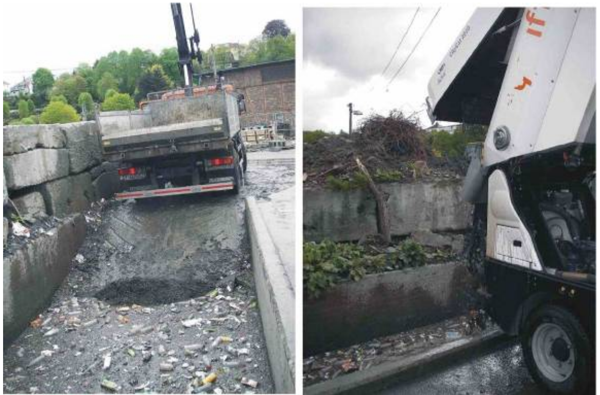
Figur 16. Masser som er kostet opp av bydrift eller kommer fra vaskestasjonen for kjøretøy slippes ned i et kar. Karet har direkte forbindelse med elven som er tidevannspåvirket. På disse bildene foregår tømming ved lavt tidevann.
