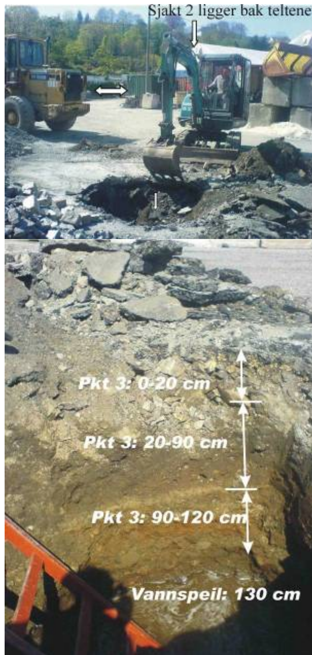
Figur 10. Bilder fra sjakt 3 med plassering av prøvepunkter.
