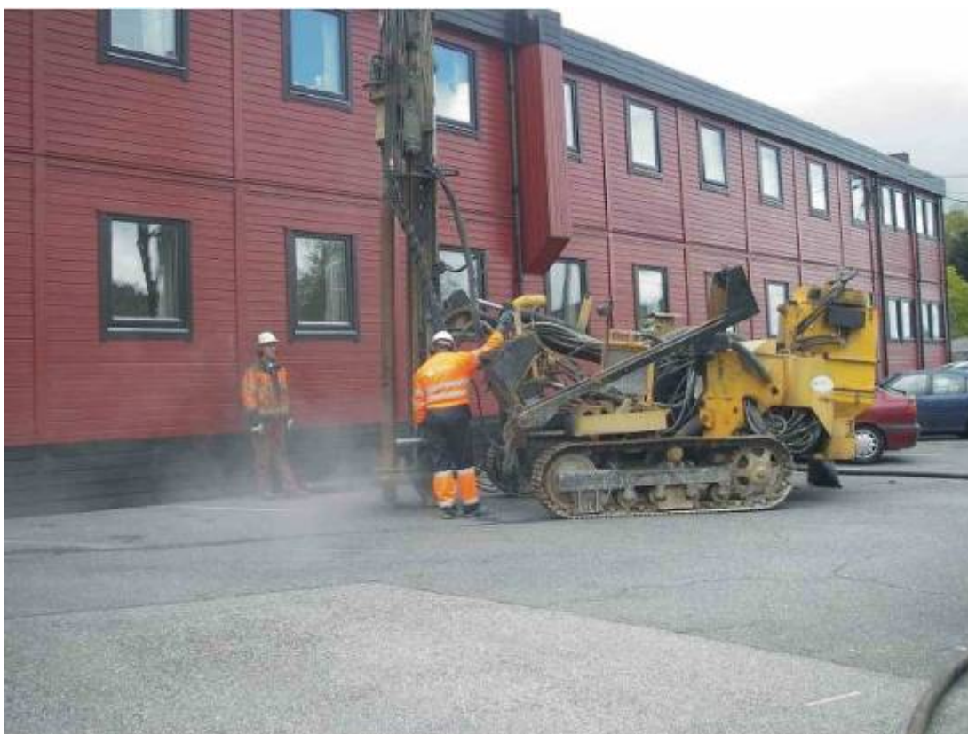
Figur 23. Borepunkt 1: Br 1 ble boret til 12 m dyp. Fjell ble truffet ved 11 m.
