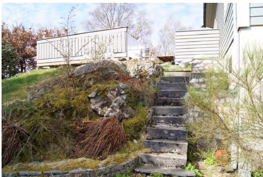
Figur 38. Sætervegen 12D, trapp sørvest for huset.
