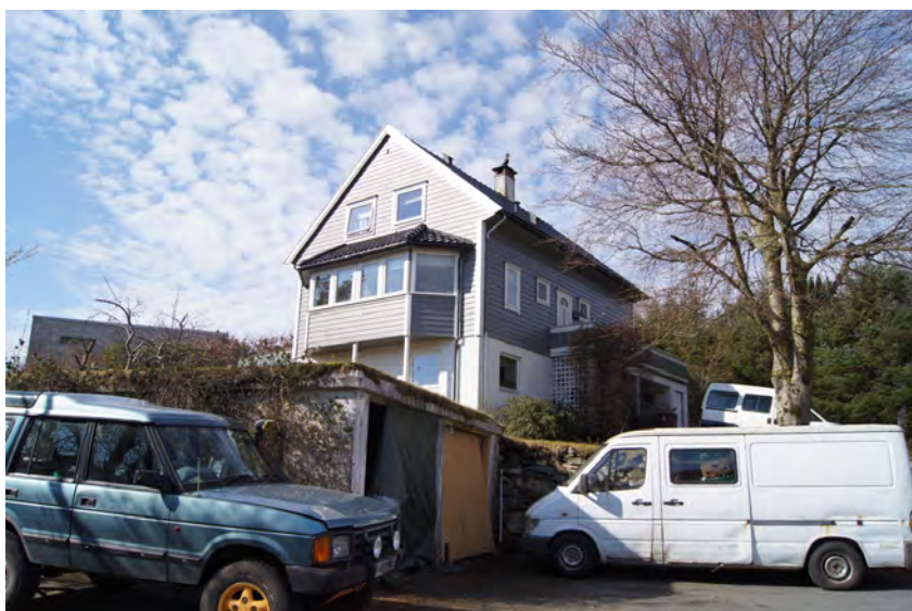
Figur 64. Sætervegen 12D, sett frå nordaust, med garasje.
