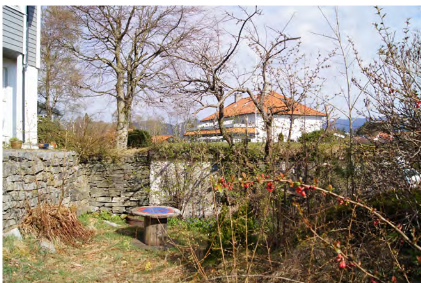
Figur 69. Sætervegen 12D, garasje sett frå sør.
