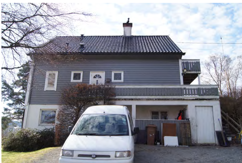
Figur 30. Sætervegen 12D, fasade mot nordaust.
