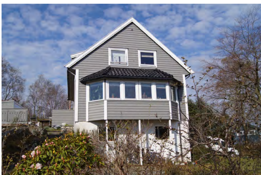
Figur 37. Sætervegen 12D, fasade mot søraust.
