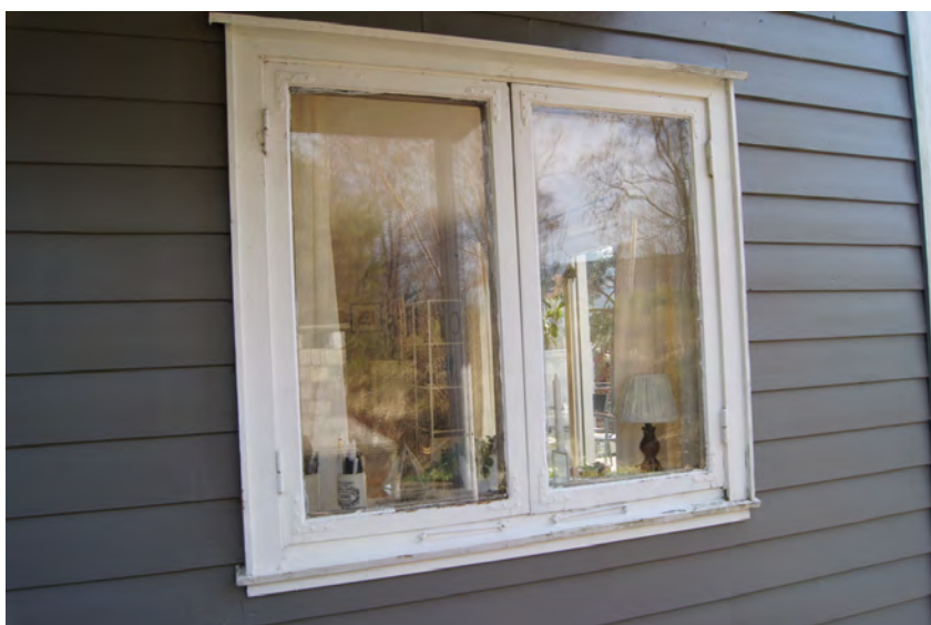
Figur 33. Sætervegen 12D, fasade mot nordvest, detalj.
