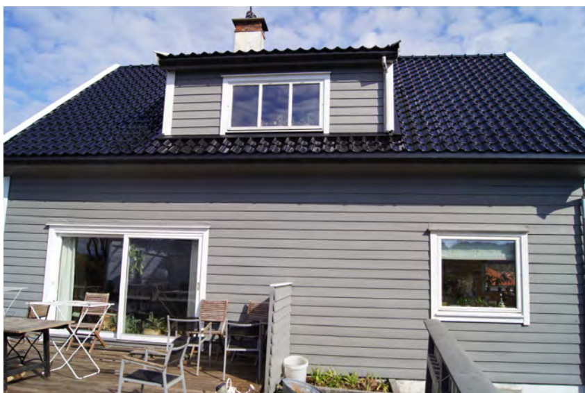
Figur 35. Sætervegen 12D, fasade mot sørvest.
