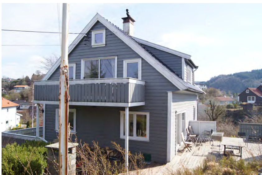
Figur 31. Sætervegen 12D, fasade mot nordvest.
