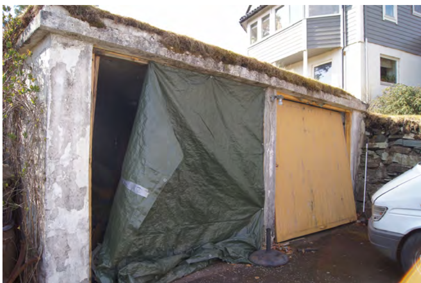
Figur 65. Sætervegen 12D, garasje.
