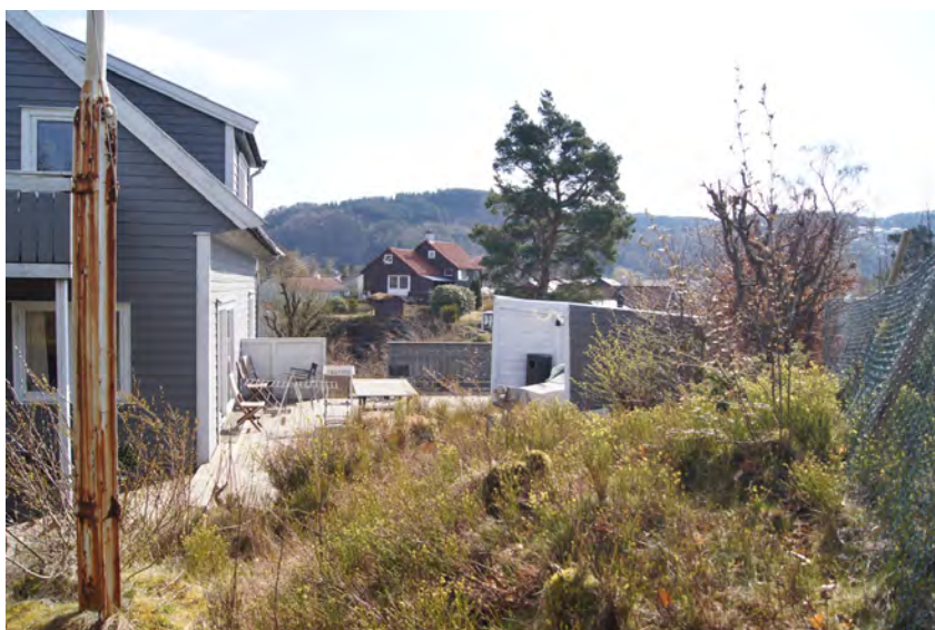
Figur 32. Sætervegen 12D, fasade mot nordvest og sørvest med terrasse.
