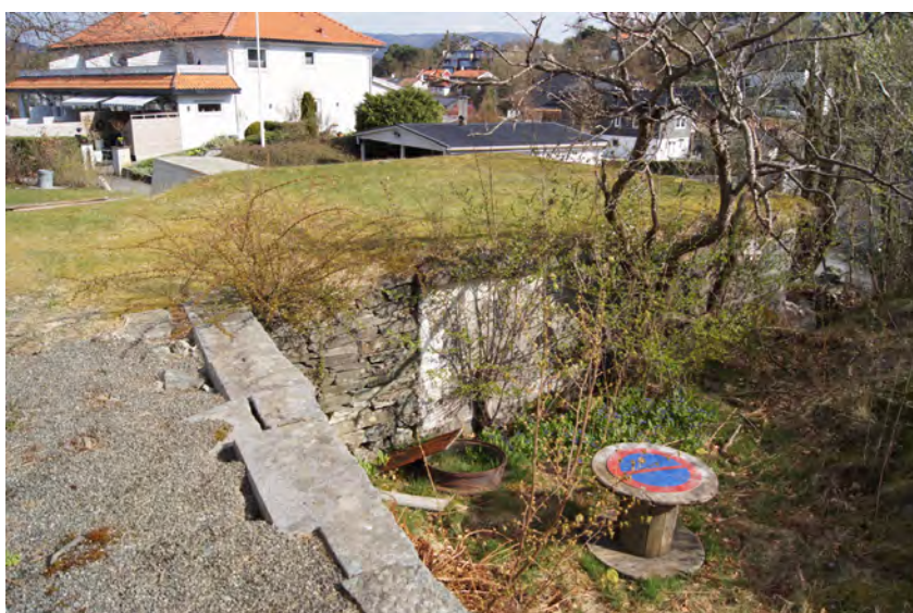
Figur 68. Sætervegen 12D, garasje sett frå sør.
