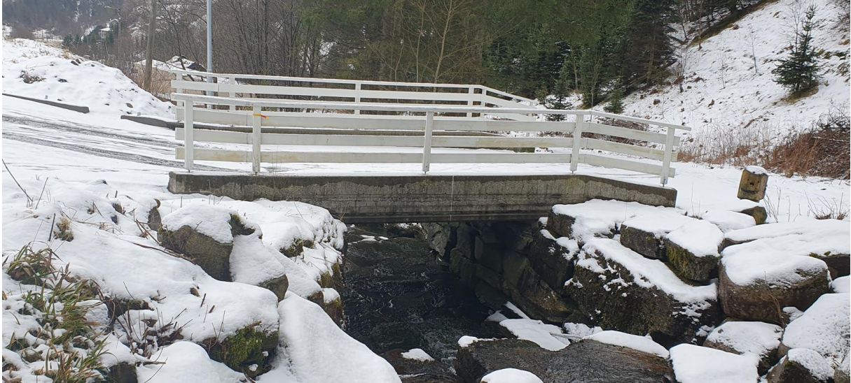
Figur 3: Bru 1 har en lysåpning på 3,3 x 2 m (horizontal x vertikal). Landkar i tørrmur. Flomvei vurdert til ut over høyre bredde.
