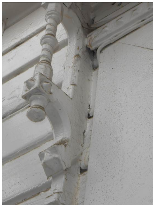
Figur 8. Treutskjæring rundt vindu. Del av rammen rundt vinduene (Foto: Byantikvaren 2015).
