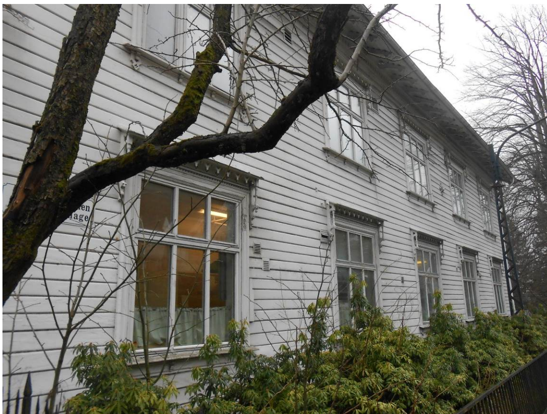
Figur 6. Østfasaden. Med unntak av vinduene er fasaden i stor grad bevart (Foto: Byantikvaren 2015).
