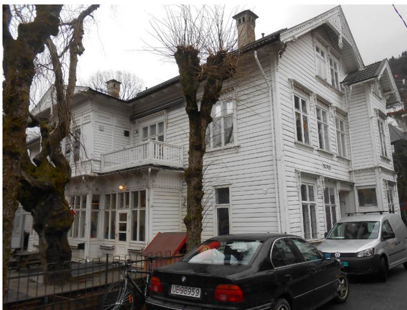
Figur 4. Fasader mot sør. Huset hadde opprinnelig en åpen veranda på denne siden. Denne er i dag bygget inn og mye endret, men de flotte jernkonsollene er fortsatt bevart (Foto: Byantikvaren 2015).
