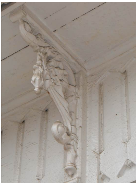
Figur 7. Støpejernskonsoll til veranda (Foto: Byantikvaren 2015).
