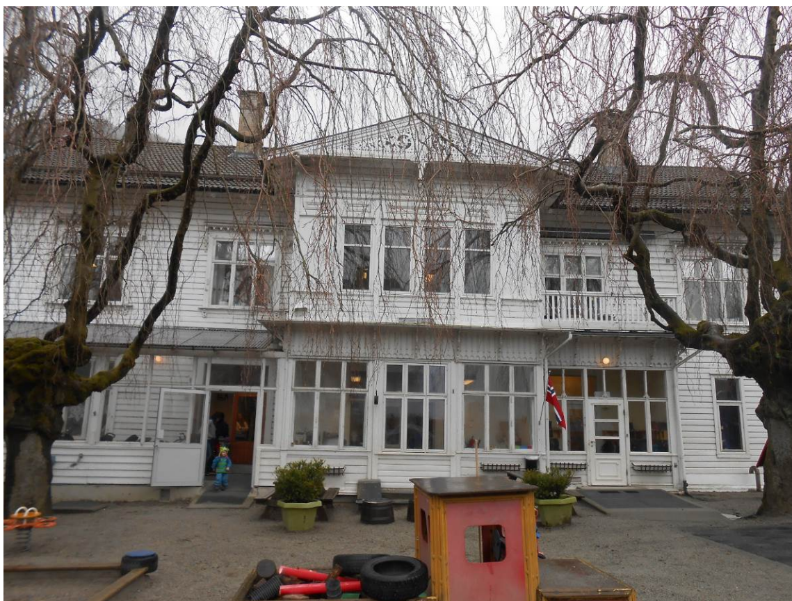
Figur 5. Vestfasaden. Bildet viser fasaden med verandaen. Hagen er i dag lekeområde med sand og lekeapparater. De gamle tærne står fremdeles (Foto: Byantikvaren 2015).
