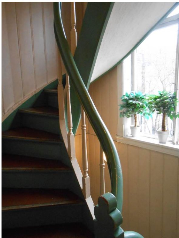
Figur 10. Originalt trappeløp. Trappeløpet i byggets sørøstlige hjørne er verneverdig (Foto: Byantikvaren 2015).
