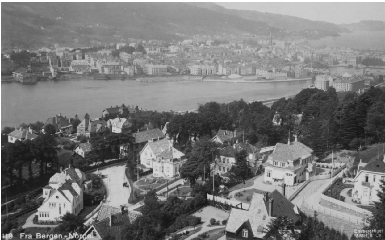
Figur 1. Kalfaret fotografert mellom 1912 og 1923 Området domineres av villabebyggelse og forseggjorte hageanlegg fra begynnelsen av 1900-tallet. Kalfarveien 43 skimtes midt i bildet (Foto: ubb-bs-pkb-00216, Marcus, UiB).
