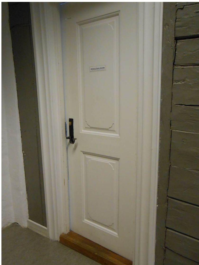
Figur 12: Eksempel på senbarokk dør (Foto, Byantikvaren 2015).
