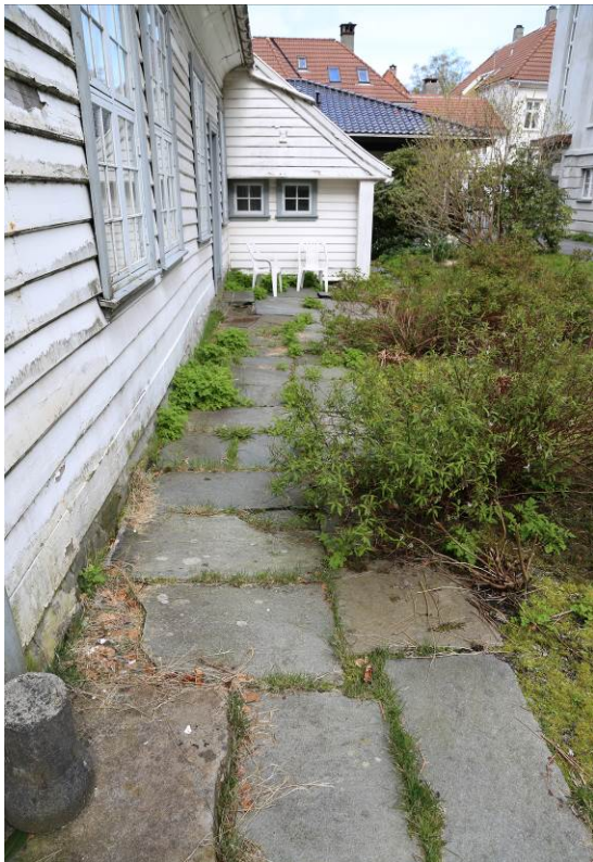
Figur 17: Rundt huset er det grusganger med felt av skiferheller (Foto: Byantikvaren 2015).
