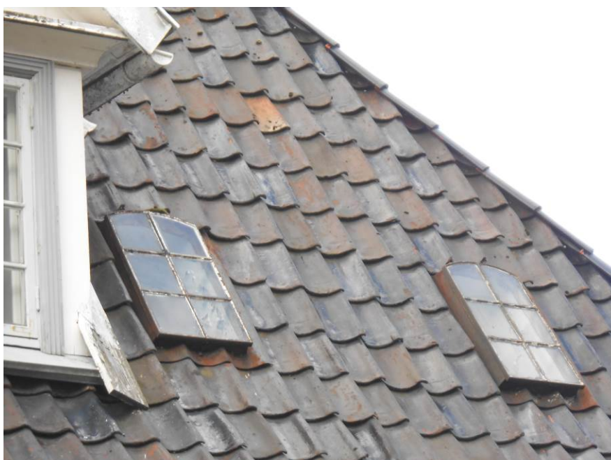
Figur 7: Takvinduer i støpejern (Kilde: Foto, Byantikvaren 2015).
