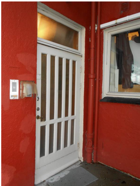
Figur 10. Sørfasaden har to ytterdører, hvorav den ene inn til garasjefløyen/vaktrom har bevart det originale dørbladet (Foto: Bergen kommune, Byantikvaren 2015).
