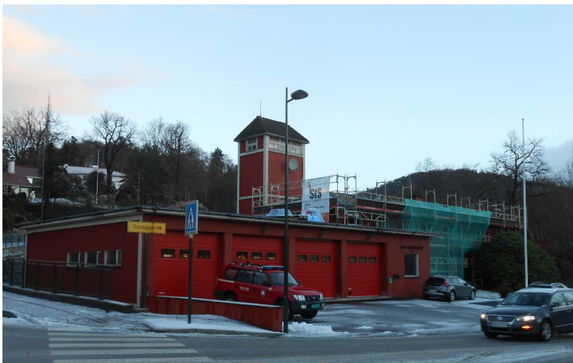
Figur 5. Bygningen fotografert fra sørvest. Stillaser er oppe rundt kontorfløyen, og taket får i disse dager (des. 2015) svart takstein (Foto: Bergen kommune, Byantikvaren 2015).
