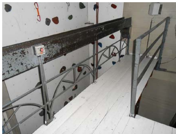
Figur 29. Øverste repos i slangetårnet har enkelt plankegulv og et originalt rekkverk i metall. Det er laget buldrevegg på innsiden av tårnet (Foto: Bergen kommune, Byantikvaren 2015).
