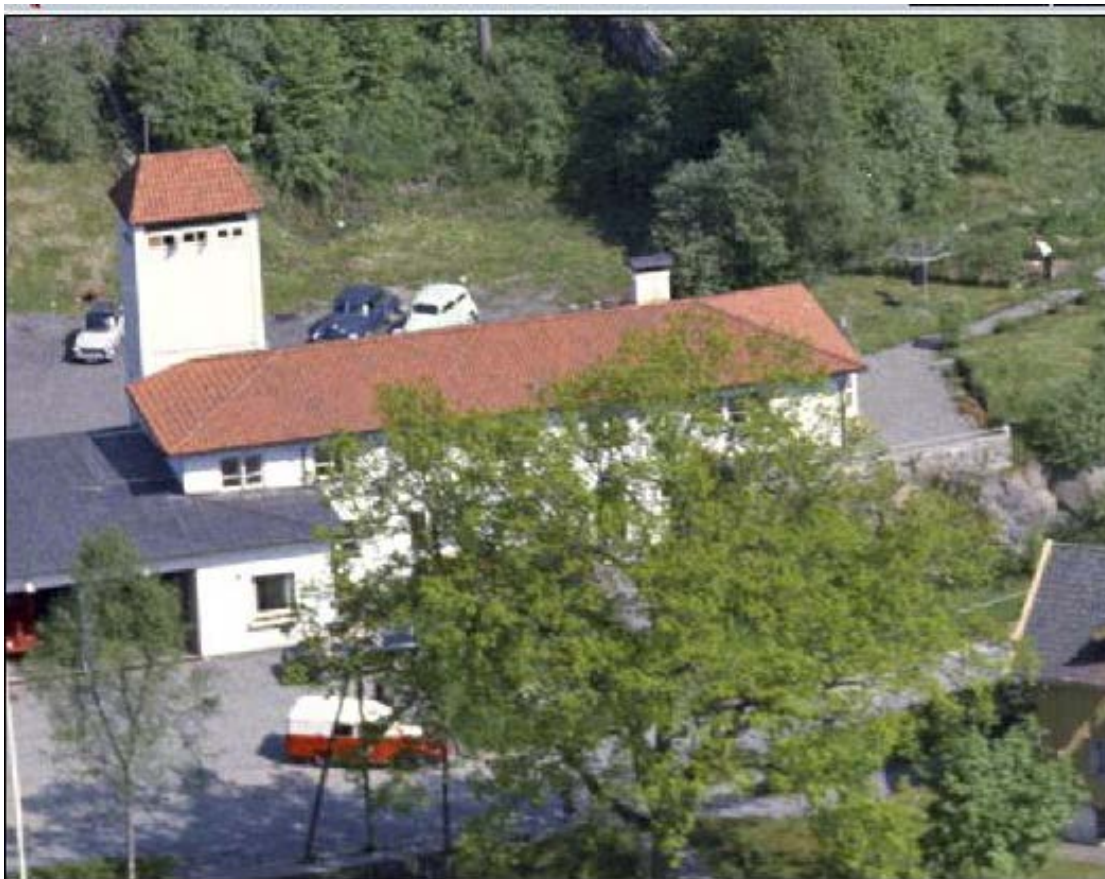
Figur 17. Her ses det markerte skillet mellom garasje- og kontorfløyen tydelig. Den viktigste forskjellen er selvsagt antall etasjer og takform. Ulik vindusinnndeling i de to fløyene, forskjøvnne etasjeplan og slangetårnet plassert akkurat på overgangen mellom de to fløyene bidrar også til å markere et skille. Det gjør også den ulike taktekkingen (Foto: Skråfoto fra UiB: UBB-W-F-149064. jpg, Årstall 1965).
