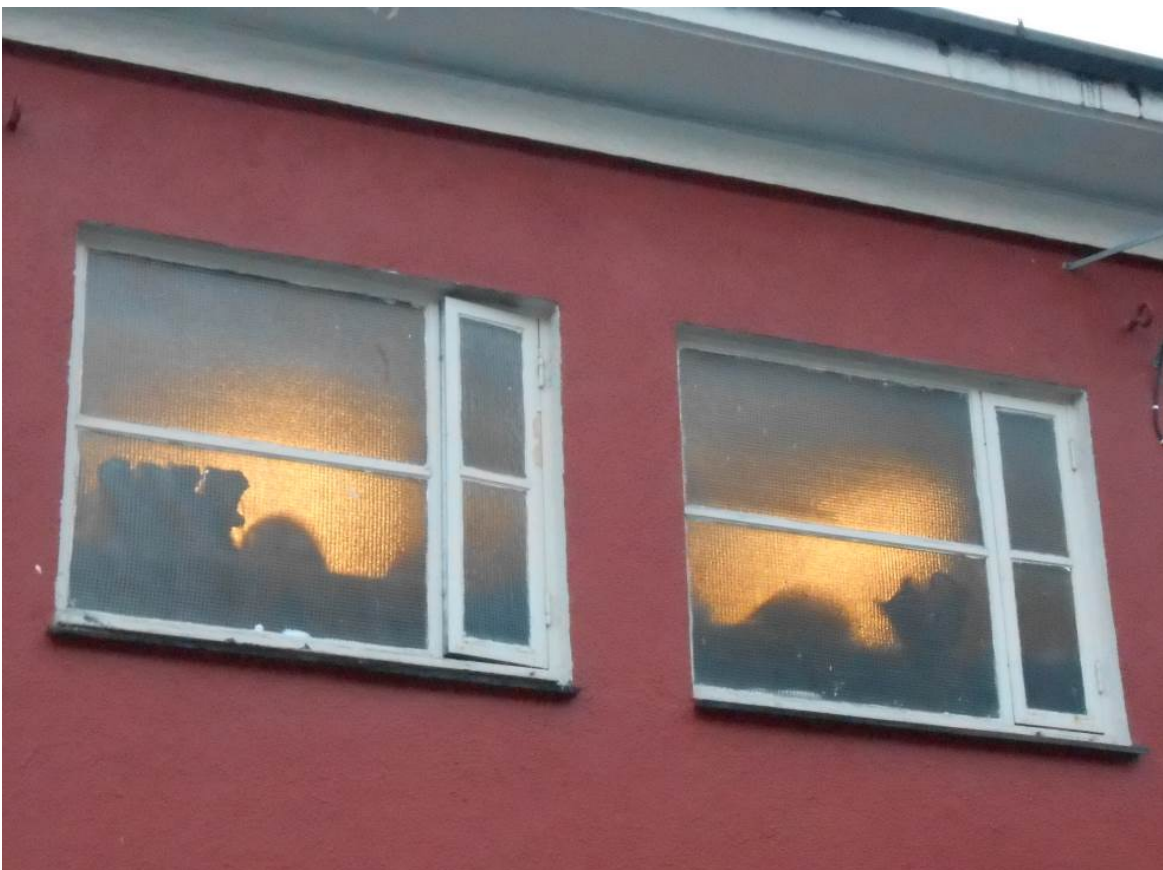
Figur 14. Trådglassvinduene i garasjefløyen er utført som store fastvindu med et lite, sidehengslet åpningsvindu på siden. Vinduene skiller seg fra klassiske vindu ved sin langsmale form og asymmetriske sprosseinndeling (Foto: Bergen kommune, Byantikvaren 2015).
