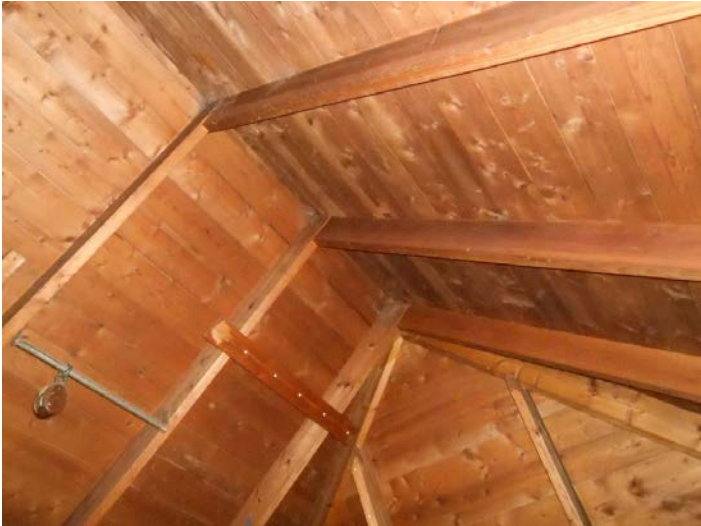
Figur 30. Åpen sperretakkonstruksjon i slangetårnet (Foto: Bergen kommune, Byantikvaren 2015).
