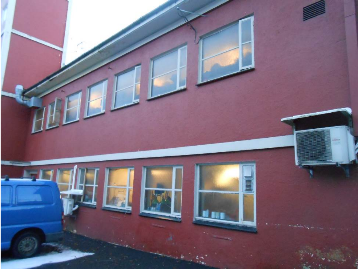
Figur 13. I garasjefløyen er alle trådglassvindue mot nord bevart, både i hovedetasje og kjeller (Foto: Bergen kommune, Byantikvaren 2015).
