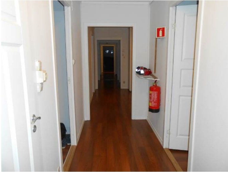
Figur 21. Nyere overflater i korridoren i andre etasje, som på 1970-tallet ble bygget om fra leiligheter til mannskapsrom, trimrom og oppholdsrom, da boplikten for mannskapet opphørte (Foto: Bergen kommune, Byantikvaren 2015).
