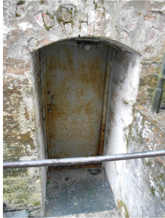
Figur 12. En trapp leder ned til en kjellerinngang i gavlveggen mot nord (Foto: Byantikvaren 2015).
