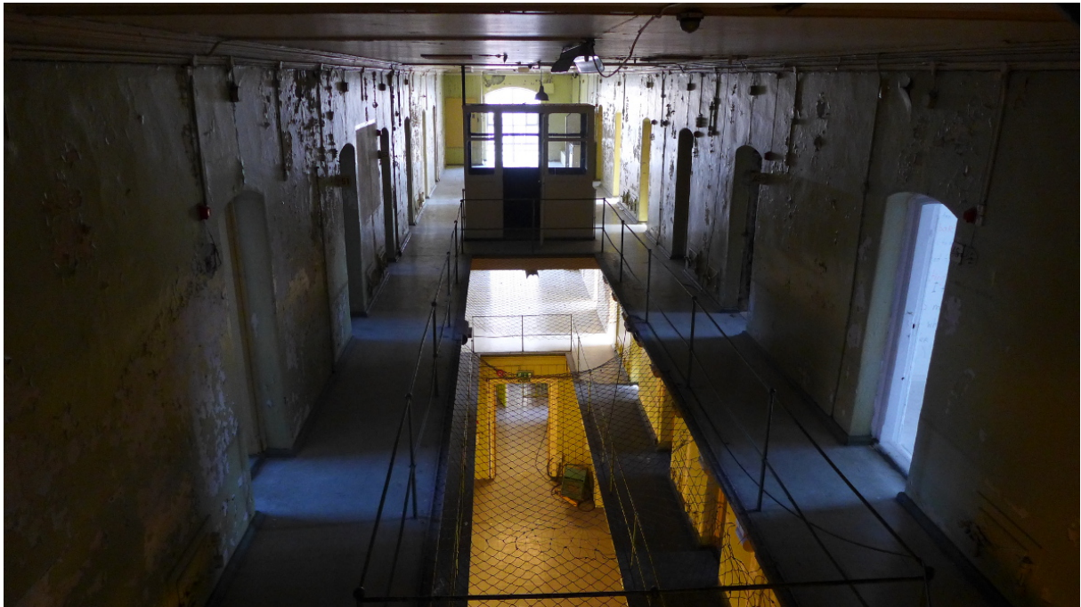
Figur 16. Planløsningen, med en sentralhall gjennom flere etasjer og gallerier med adkomst til cellene, var vanlig for fengsler som ble bygget midten av 1800-tallet (Foto: Byantikvaren 2015).
