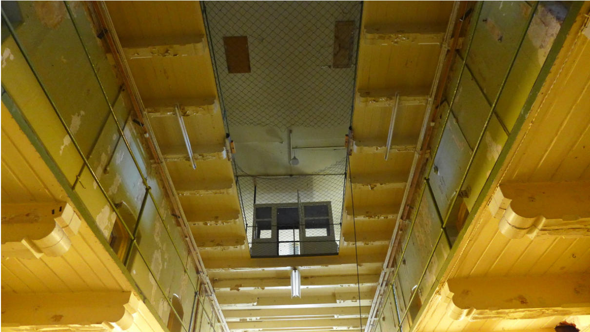
Figur 9. Bjelkelag mellom etasjene er av tre, der profilerte bjelker stikker ut i den sentrale hallen og bærer galleriene (Foto: Byantikvaren 2015).
