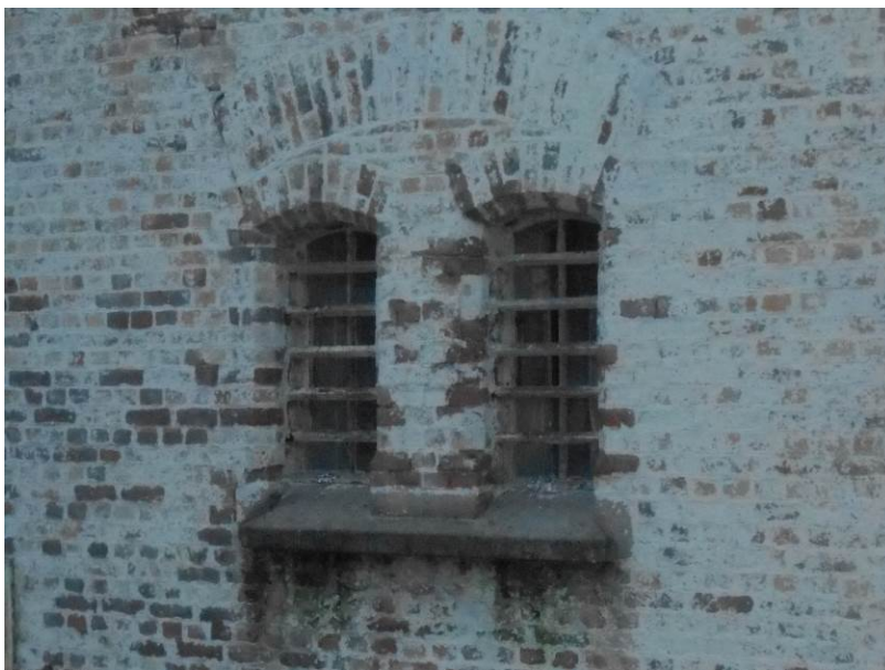
Figur 13. Cellevinduer med gitter (Foto: Byantikvaren 2015).
