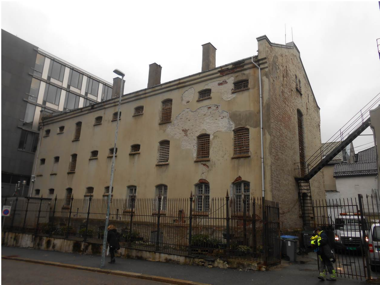
Figur 10. Fasade mot Rådhusgaten (Foto: Byantikvaren 2015).
