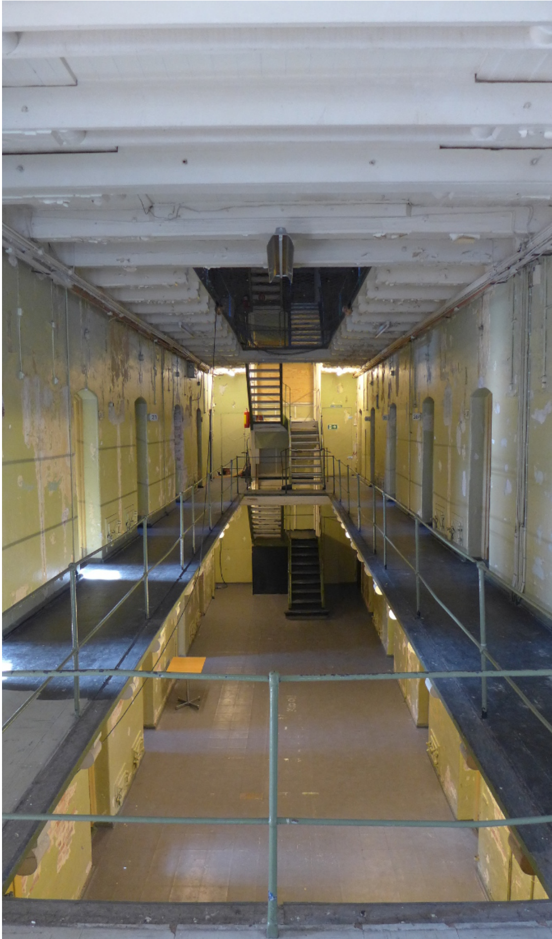
Figur 15. Sentralhallen går gjennom flere etasjer og har gallerier med adkomst til cellene (Foto: Byantikvaren 2015).
