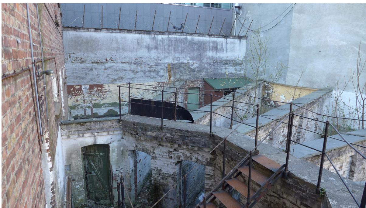
Figur 18. Luftegårdene er organisert i en vifteform og ligger på vestsiden av hovedbygningen (Foto: Byantikvaren 2015).
