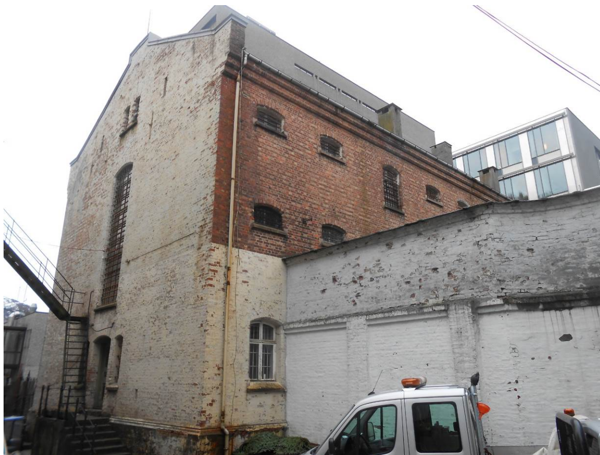
Figur 8. Gavlvegg mot øst og langsiden mot nord med upusset tegl i 2. og 3. etasje. Opprinnelig fremstod hele bygningen i upusset tegl (Foto: Byantikvaren 2015).
