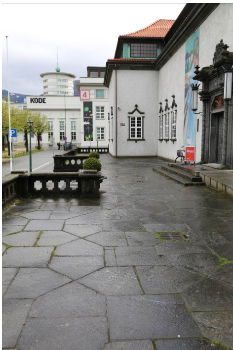
Figur 25. Terrasse med hardangerskifer lagt i mønster (Foto: Byantikvaren 2015).
