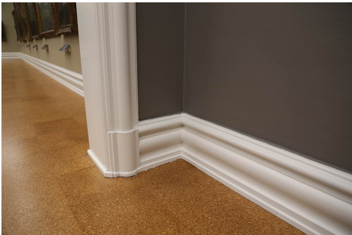
Figur 19. Detalj av den gulvlist med profiler samt originalt korkgulv (Foto: Byantikvaren 2015).
