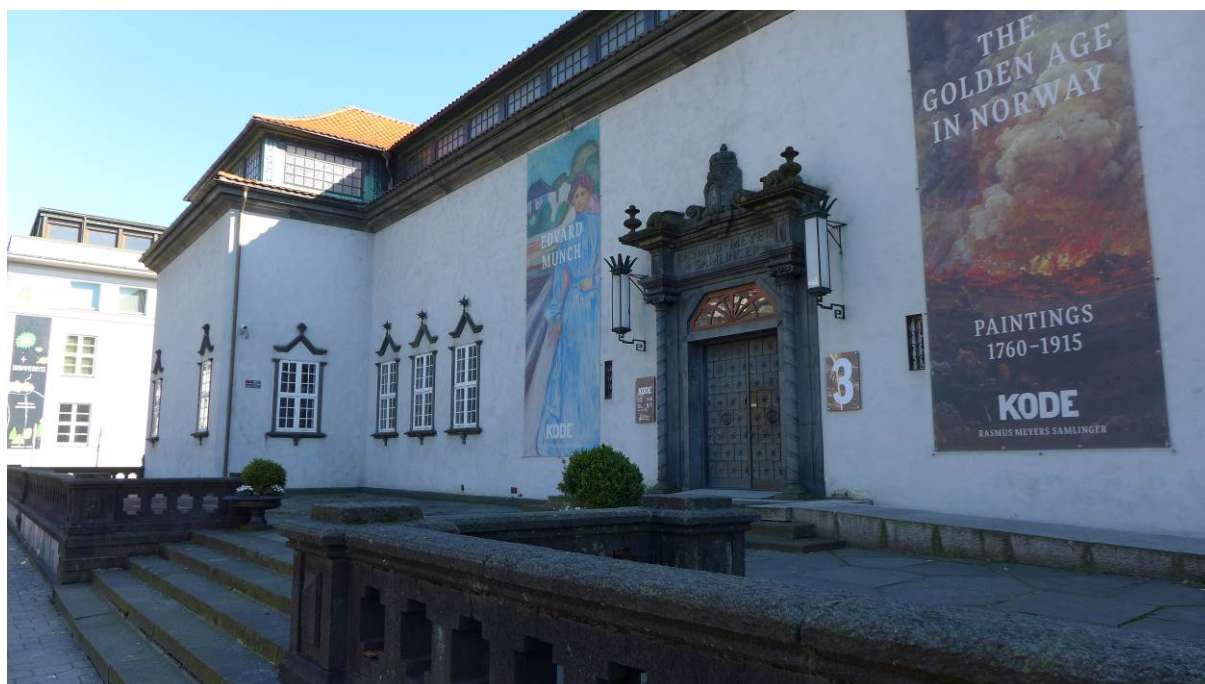
Figur 24. Bred trapp som leder opp til terrasse med balustrade rundt (Foto: Byantikvaren 2015).
