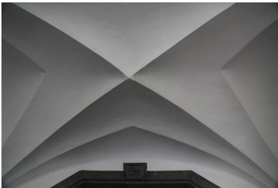
Figur 8. Krysshvelvtak i vestibyle (Foto: Byantikvaren 2015).
