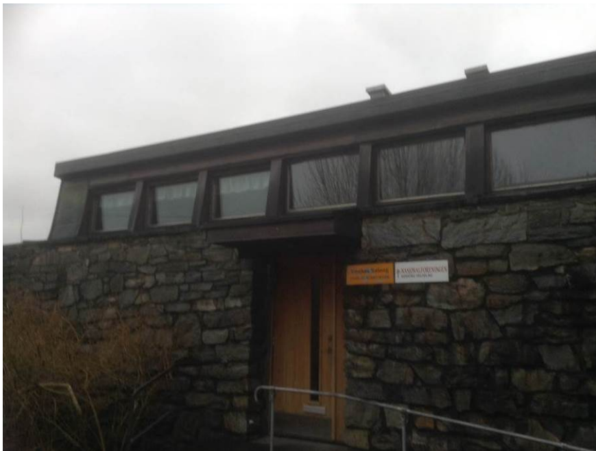
Figur 7. Vaktmesterbolig, fasade mot sør (Foto: Byantikvaren 2015).
