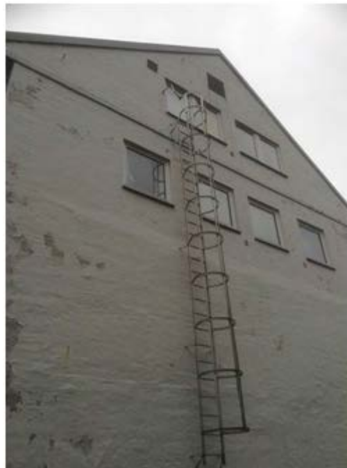
Figur 10. Gavlfasade mot sør (Foto: Byantikvaren 2015).
