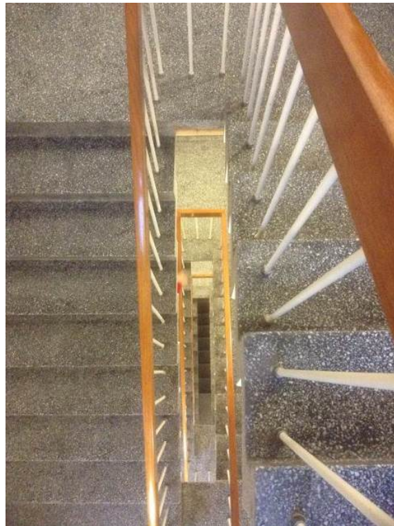
Figur 16. Trappeoppgang (Foto: Byantikvaren 2015).
