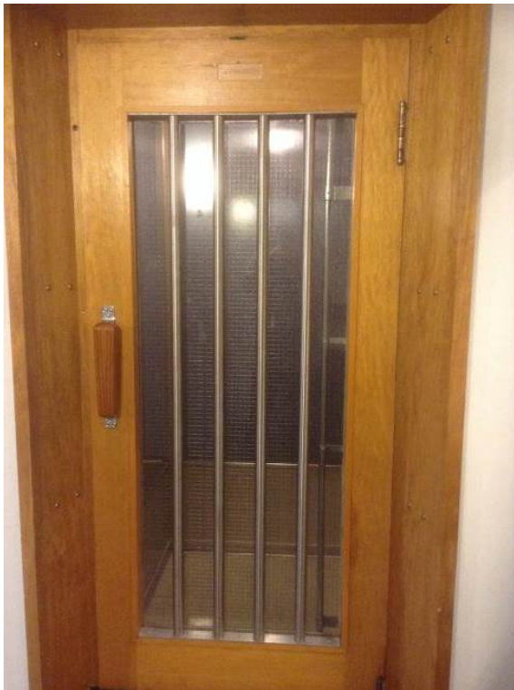
Figur 15. Opprinnelig heisdør (Foto: Byantikvaren 2015).
