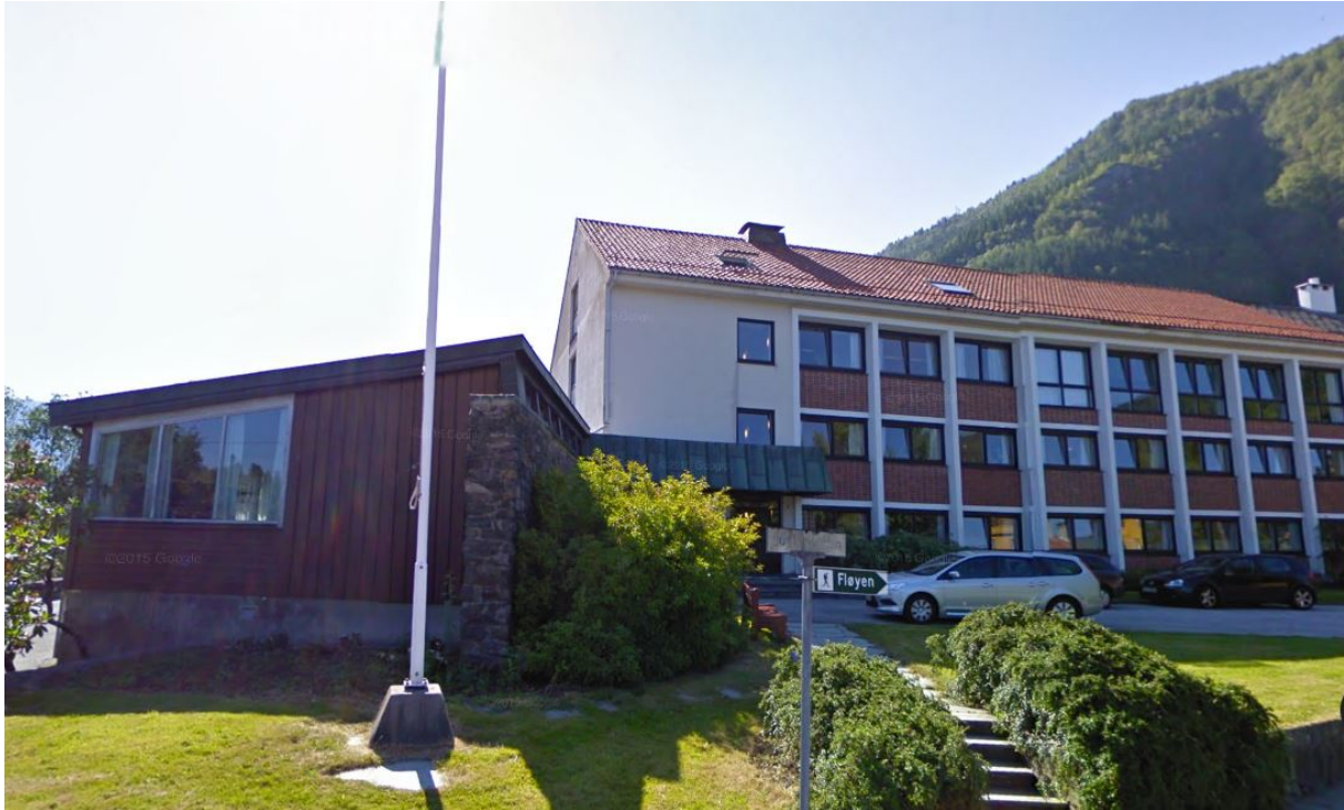
Figur 6. Hovedfasade og tidligere vaktmesterbolig (Kilde: Googlemaps).
