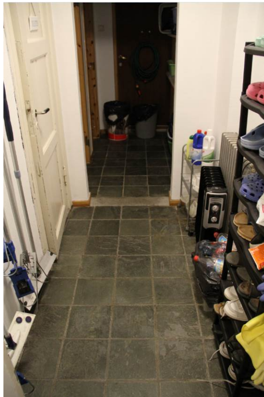
Figur 36: Enda et eksempel på originalt skifergulv (Foto: Byantikvaren, 2015).
