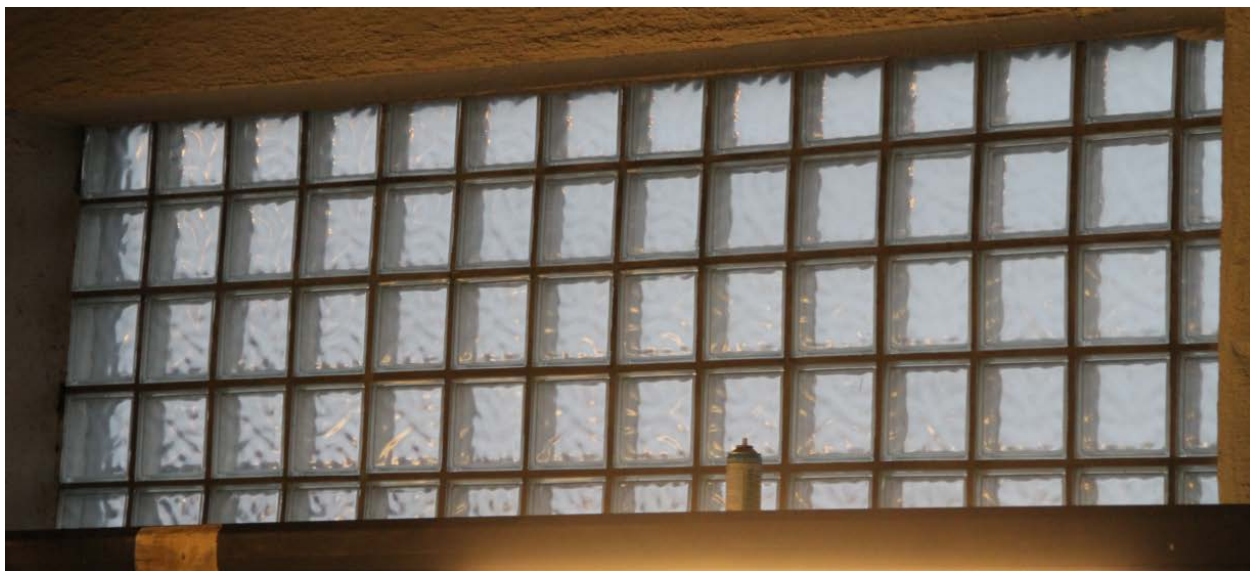
Figur 11: Dagens glassbyggersteinvindu i garasjedelen av bygningen (Foto: Byantikvaren 2015).
