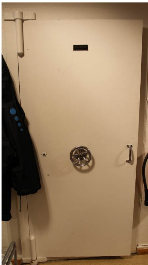
Figur 30: Opprinnelig dør inn til rom med pengeskap (Foto: Byantikvaren, 2015).
