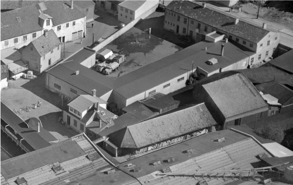
Figur 3: Flyfoto av hele anlegget fra 1955, her ser vi at det var tett med industri i området på den tiden (Kilde: Widerøe, w-sh-119833, 1955).
