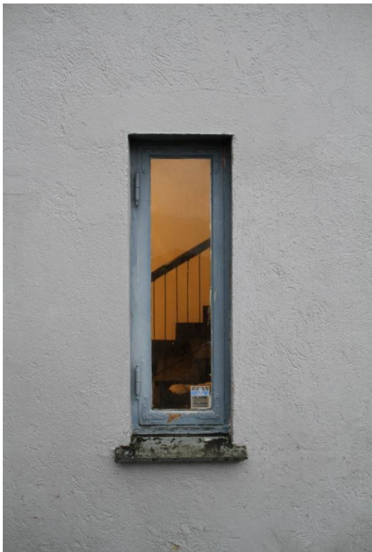
Figur 19: Vindu i trappefløy, fasade mot øst (Foto: Byantikvaren 2015).
