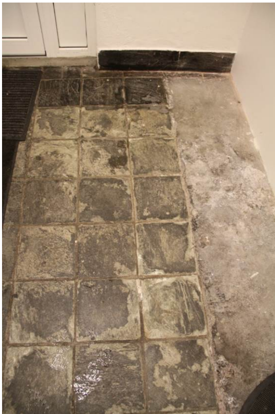
Figur 35: Det opprinnelige skifergulvet er bevart flere steder (Foto: Byantikvaren, 2015).
