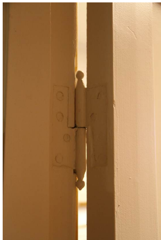
Figur 34. En rekke opprinnelige bygningsdetaljer er bevart, her eksemplifisert ved dørhengsler (Foto: Byantikvaren, 2015).
