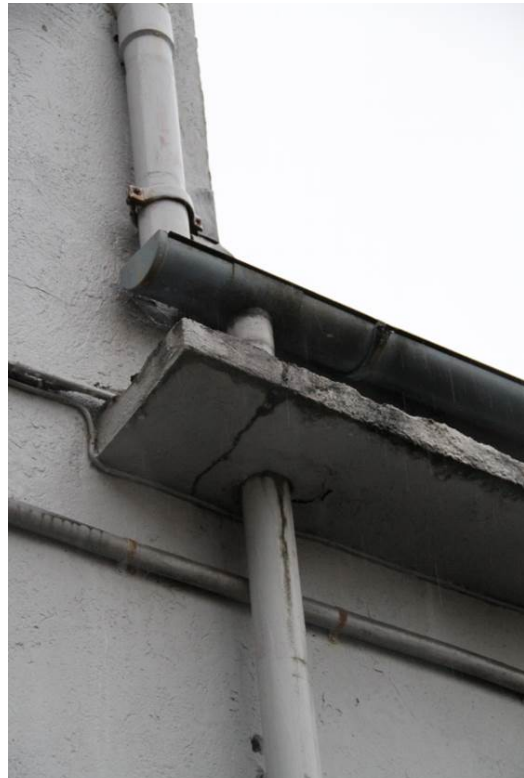
Figur 20: Detalj av takrenne som går gjennom gesims (Foto: Byantikvaren, 2015).
