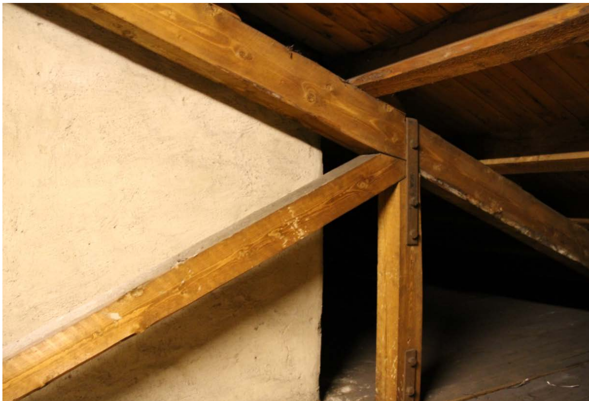
Figur 29: Detalj av takkonstruksjon på loft (Foto: Byantikvaren, 2015).
