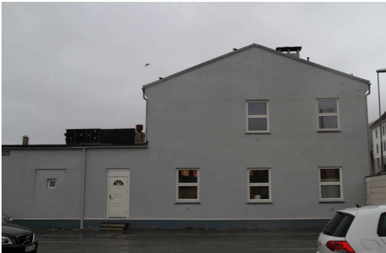
Figur 10: Deler av dagens fasade mot vest. Her ser vi at vinduer er skiftet og at det har kommet et tilbygg som har «visket ut» garasjetilbyggets saksing på fasade mot nord (Foto: Byantikvaren 2015).
