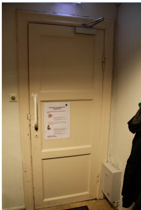
Figur 33: Original dør med nytt håndtak i første etasje (Foto: Byantikvaren, 2015).
