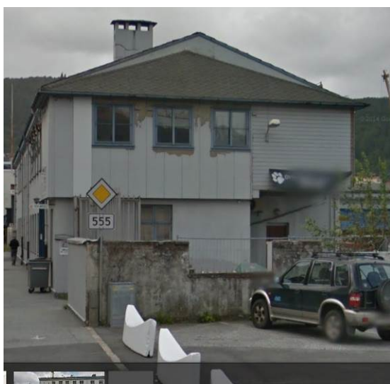
Figur 13. Dagens fasade mot nord (Foto: Byantikvaren, 2015).
