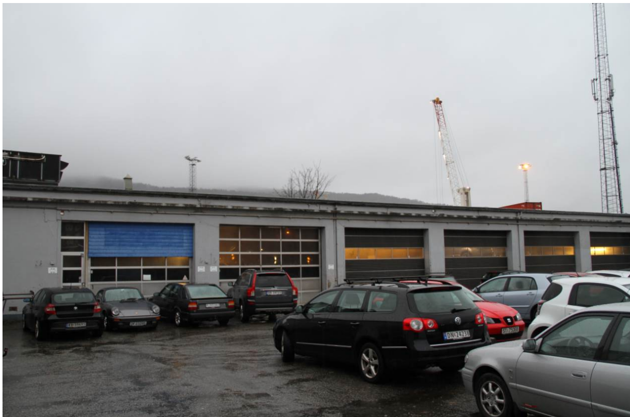
Figur 16: Fasade mot øst med garasjedelen, hvor det i dag er bilverksted (Foto: Byantikvaren, 2015).
