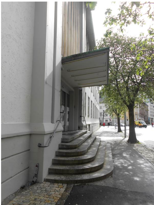
Figur 9: Den tynne, utkragede baldakinen er karakteristisk for funksjonalismen (Foto: Byantikvaren 2015).
