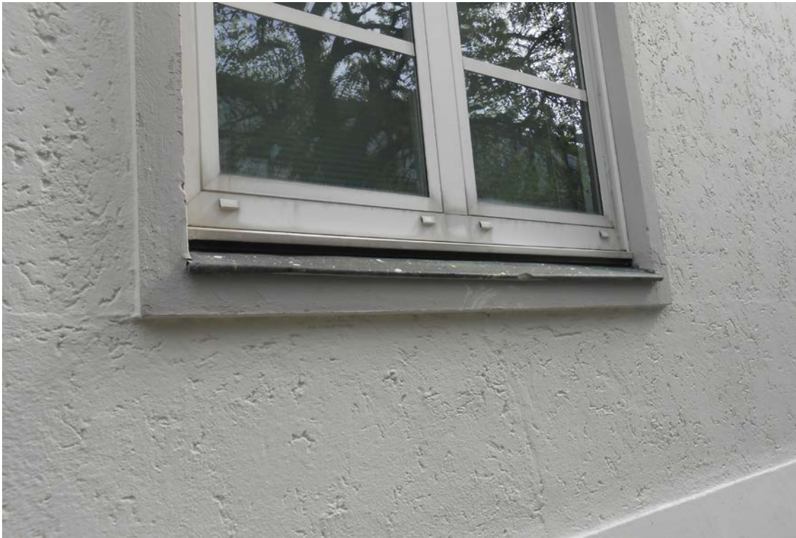
Figur 7: Såkalt mott-puss. Denne strukturen går igjen i de fleste pussede overflater både ute og inne over det meste av hele bygningskomplekset (Foto: Byantikvaren 2015).
