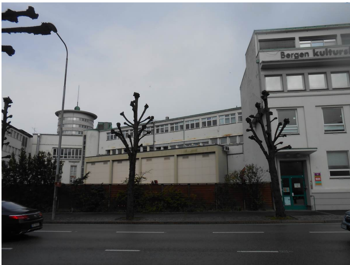
Figur 13: Sekundærstasjonen til høyre har på denne siden preg av å være bakgårdsfasade. Det var egentlig planlagt en bygning til langs Strømgaten som ikke ble oppført. Foran tårnsalsoppbygget ser vi spiraltrappen, som er markert i fasaden som et rundt trappetårn (Foto: Byantikvaren 2015).
