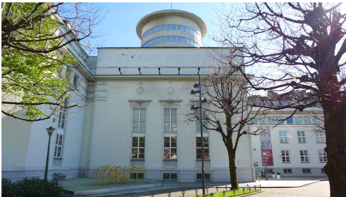
Figur 11: Tårnfløyen skiller seg ut med vertikale, sprossede vindusbånd og fasadedekor som understreker tårnets høyde. Dette fasademotivet er videreført i nybygget fra 1945 (til venstre i bildet). Vi ser også hvordan gesimsen binder nytt og gammelt sammen (Foto: Byantikvaren 2015).
