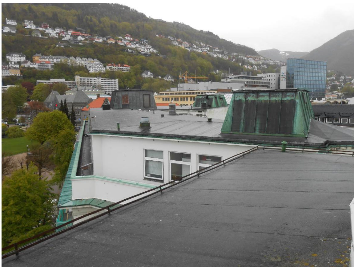
Figur 14: Taket på Kulturskolen har tre takoppbygg beslått med kobber. Hovedgesimsen nederst står også med kobber, mens den øverste nylig har blitt erstattet av grønnlakkert aluminium (Foto: Byantikvaren 2015).
